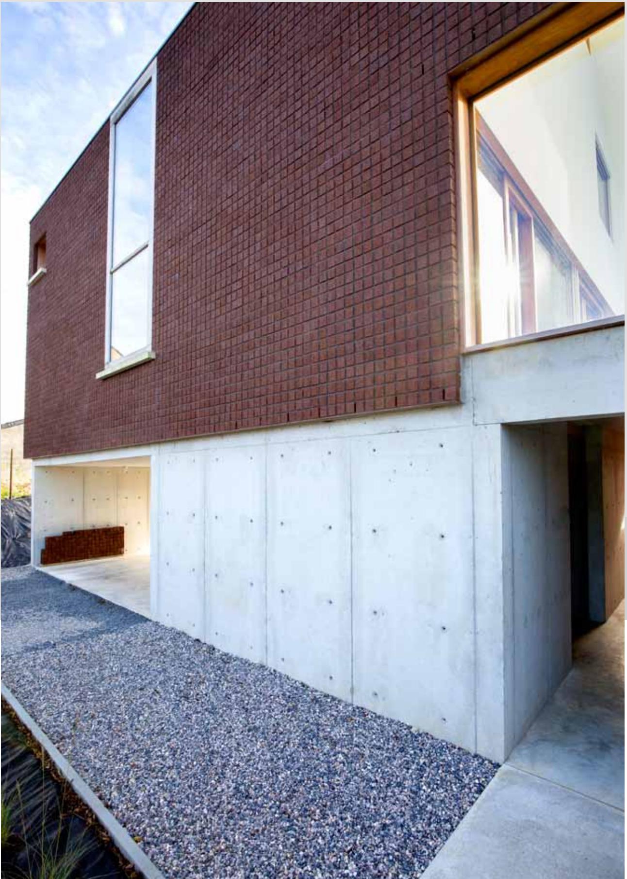
De gebruikte materialen zijn een interpretatie van het regionale architecturale vocabularium. De betonwanden verwijzen naar de onderbouw in kalksteen, terwijl het parement in vierkante baksteen refereert aan de terracottategeltjes en het baksteenmetselwerk in de naburige hoeses.
