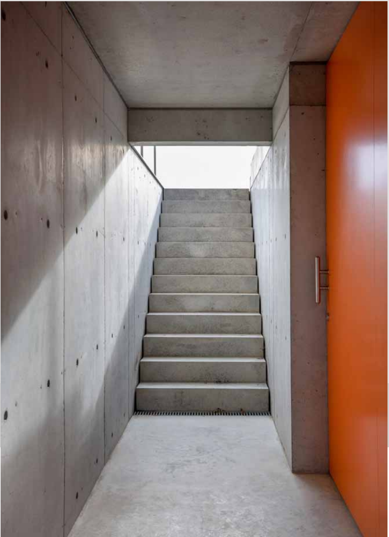
De architect én de opdrachtgever zijn wel te vinden voor de technische oplossing die het gebruik van beton impliceert. Beiden hebben iets met de betonprojecten van de Zwitserse architect Snozzi. De wanden blijven zoals ze uit de bekisting komen, en het beton verschijnt voor wat het is: een levende materie met nuances en onregelmatigheden die een gevoelige sfeer wekken.
