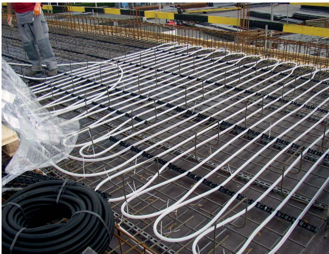
TABS, geïntegreerde thermische activering van betonplaten
