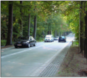
Renovatie van de Lorrainedreef in Brussel Foto : Diatheek FEBELCEM
