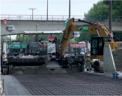
entre-distance de 120 centimètres. Ces amorces de fissuration conduisent le béton à se fissurer à ces endroits précis, ce qui permet d'atteindre naturellement l'entre-distance idéale entre fissures pour un bon comportement du revêtement. Le risque de dégradation prématurée du revêtement est ainsi évité, ce qui prolonge considérablement la durée de vie du revêtement.
