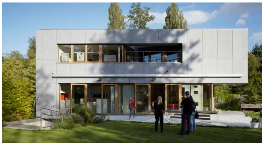
© arch. HASA - foto A. Nullens
