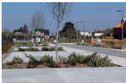
Parkeerterrein in waterdoorlatende betonverharding, Dreux (Frankrijk) © CIMbéton
