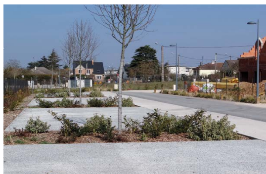
Parkeerterrein in waterdoorlatende betonverharding, Dreux (Frankrijk) © CIMbéton
