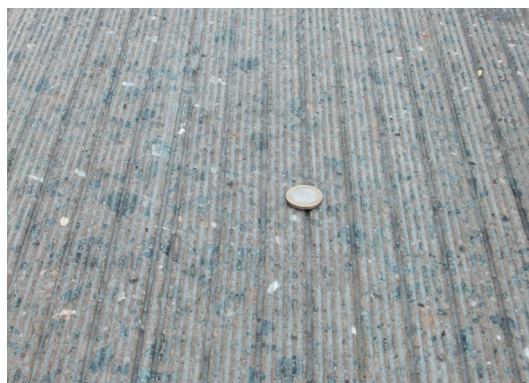
Grinding machine in dienst en een afgewerkt, zeer geluidsarm oppervlak dankzij de techniek van “Next Generation Concrete Surface”
