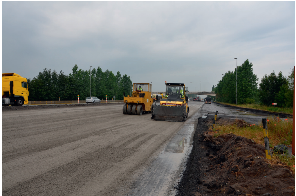
Hydraulisch gebonden funderingen worden toegepast in structuren van zwaar belaste wegen, met inbegrip van autosnelwegen ©FEBELCEM
