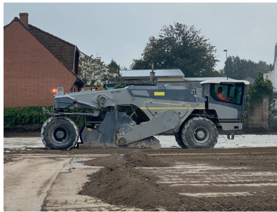
In-situ grondbehandeling d.m.v. een recycler ©CBR
