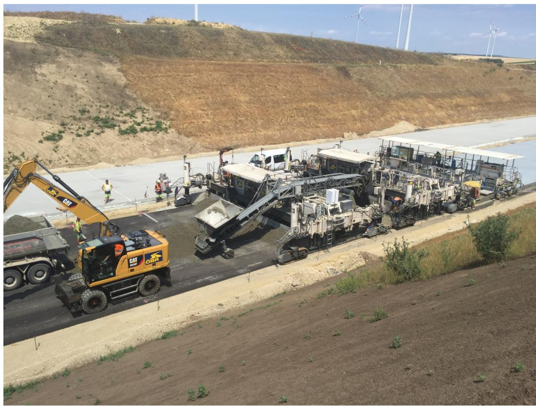
*Photo couverture: Recyclage d'un revêtement béton – autoroute E17, De Pinte, Belgique*
