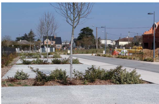
Parking en revêtement de béton drainant, Dreux (France) © CIMbéton
