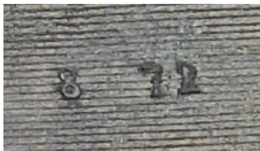
Autoroute belge E40/A3, construite comme un revêtement en béton armé continu de 20 cm d'épaisseur : en service depuis cinquante ans
