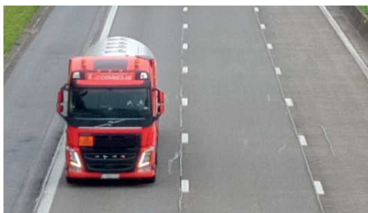
Autoroute belge E40/A3, construite comme un revêtement en béton armé continu de 20 cm d'épaisseur : en service depuis cinquante ans
