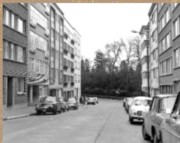
Fotos IV & V: Egyptenarenstraat (Boondaalwijk in Elsenne): jaren '60 en vandaag
