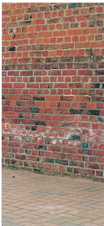
5 - Uitbloeiing veroorzaakt door uit de bodem afkomstige zouten
