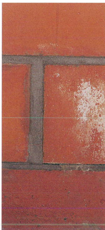
6 - Uitbloeiing in de vorm van lokale ophoping van zoutkristallen (binnenmuur)
