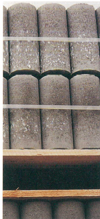
3 - Secundaire uitslag op onbeschutte prefab-elementen
