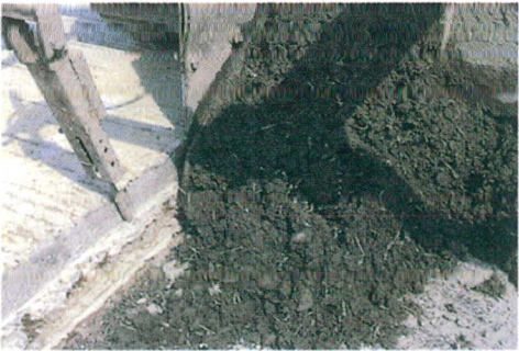
Homogene vezelverdeling in de betonspecie.
