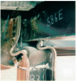
Fig. 14 - Afname van de stijfheid van beton en staal [bron: FEBELCEM]
