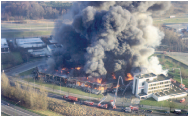
De totale vernieling van een gebouw door het ontbreken van compartimentering belast het milieu zwaar [foto Guido Coolens]
