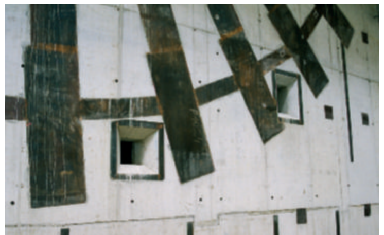
Complex industrieel gebouw in ZVB, in situ gestort
