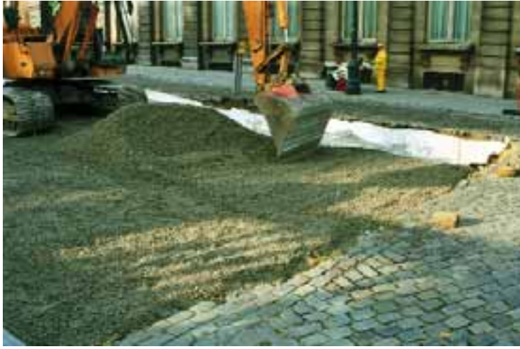
VOORBEELD VAN REALISATIE VAN FUNDERING IN POREUS MAGER BETON (Hertogsstraat, Brussel)
