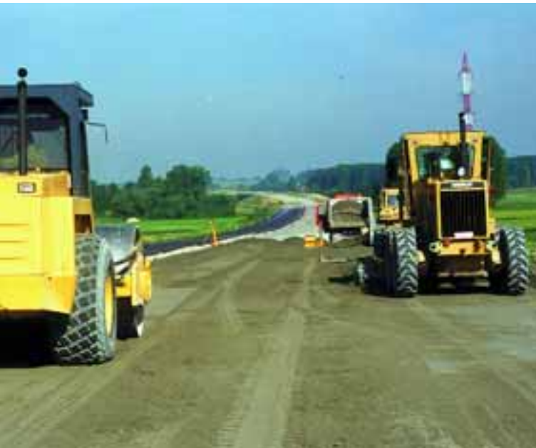
Verwerking van het zand-cement met scraper en trilwals.
