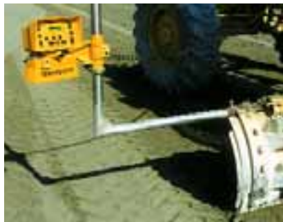
Het regelen van dwars- en lengteprofiel gebeurt met een laser. De vlakheid van het oppervlak wordt gecontroleerd met een rij van 3 m.
