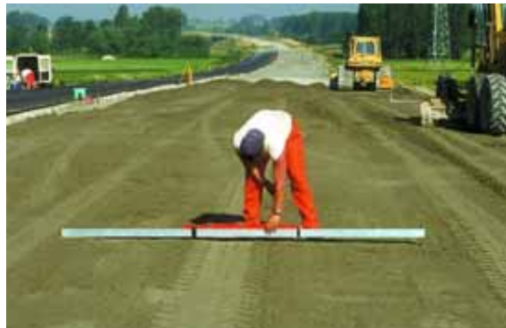
Het regelen van dwars- en lengteprofiel gebeurt met een laser. De vlakheid van het oppervlak wordt gecontroleerd met een rij van 3 m.
