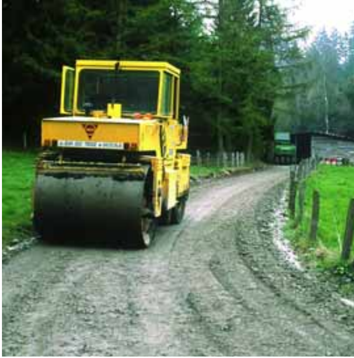
Steenslag behandeld met cement moet krachtig verdicht worden, en wel zo snel mogelijk na de fabricage van het mengsel.
