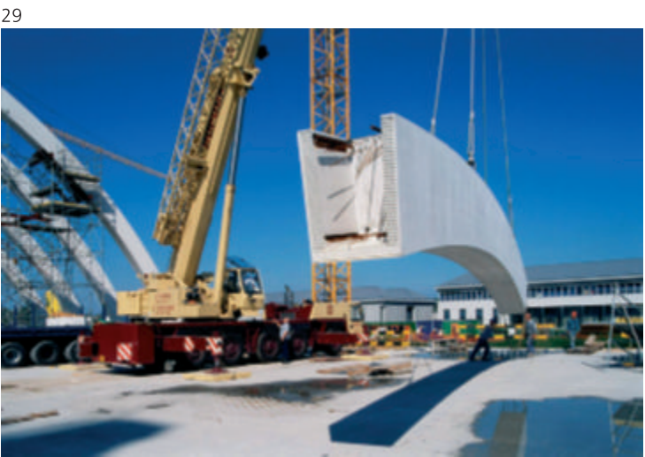
29. Montage van de boogdelen Zicht op de uitsparingen en het zaagtandoppervlak ter hoogte van verbindingsknoop
