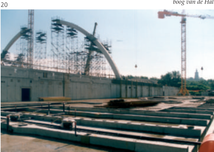
20. Zicht vanaf de koer van de Archieven Voorgrond : ribben waarop de breedplaten van de koer en de annex rusten Achtergrond : langse betonwand Archieven + montage van de eerste boog van de Hal
