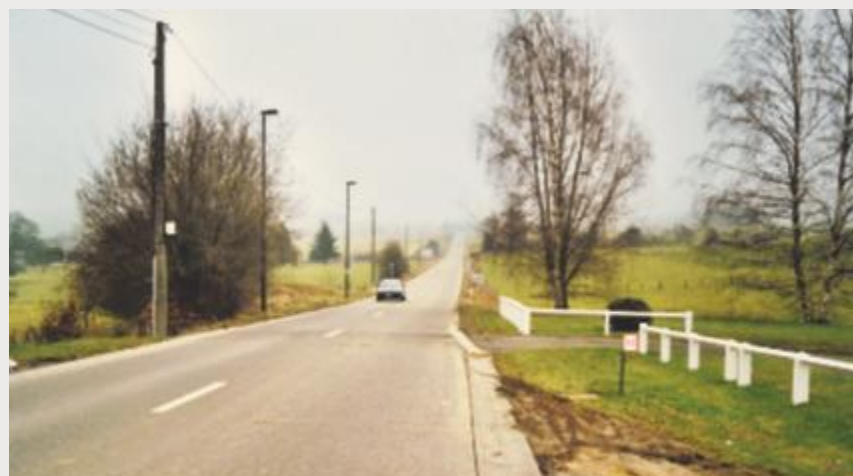
Voorbeeld van een rijweg na recyclage in situ. Ook primaire wegen komen in aanmerking voor deze renovatietechniek.
