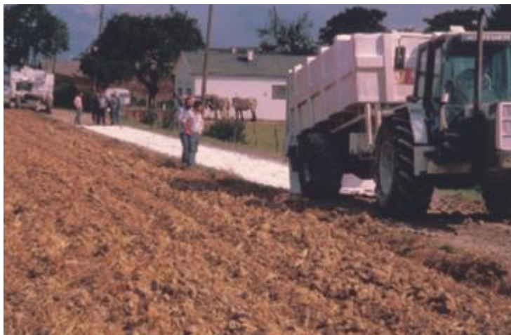
Modernere machines strooien een vaste hoeveelheid bindmiddel per m 2 .
