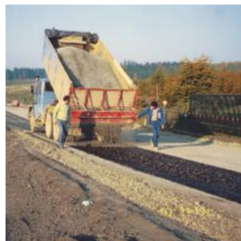
Emulsie- en zandlaag als bescherming tegen uitdrogen.
