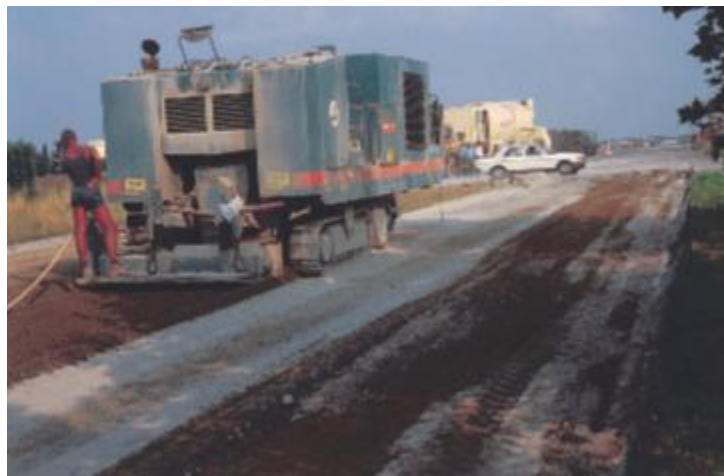
'Atelier de Reconditionnement de Chaussées' : menging gebeurt zowel in dwars- als in langsrichting.
