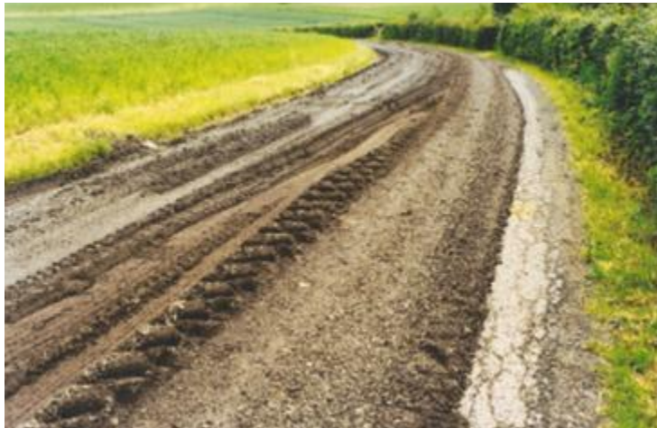
Een laag toevoegmateriaal werd uitgespreid op het bestaande wegdek.
