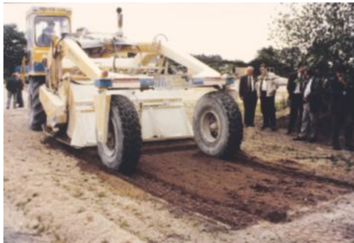
'Pulvimixers' worden voornamelijk gebruikt voor grondstabilisatie.
