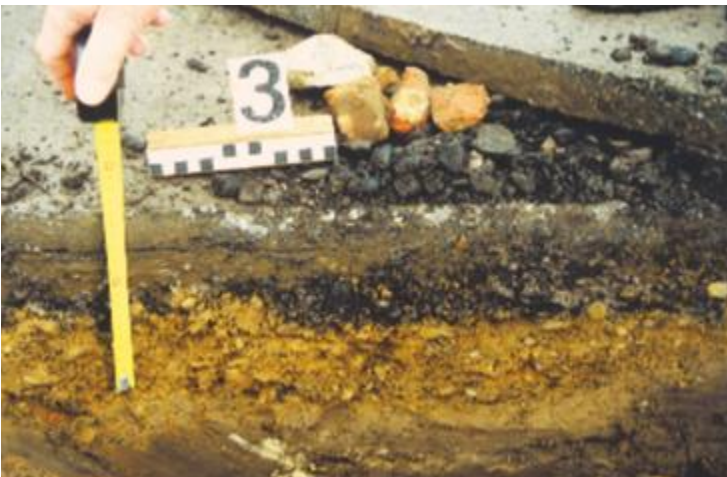
... en is minstens even diep als de dikte van de te recycleren laag.
