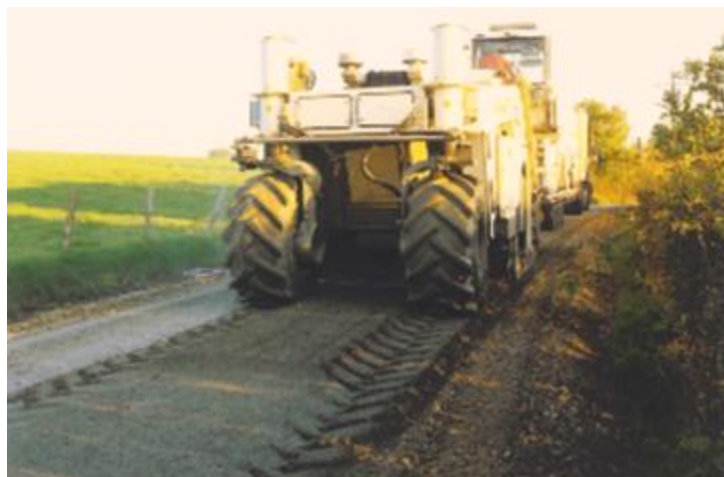
'Recyclers' zijn zware machines die ook dikke lagen in één gang grondig mengen.
