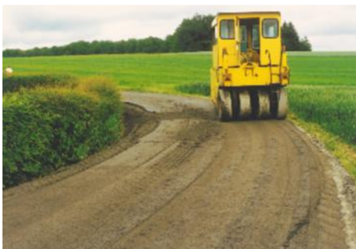
Dikkere lagen worden extra verdicht met een bandenwals.
