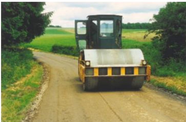
Dikkere lagen worden extra verdicht met een bandenwals.
