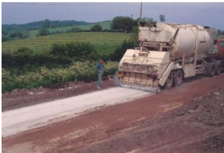
Modernere machines strooien een vaste hoeveelheid bindmiddel per m 2 .
