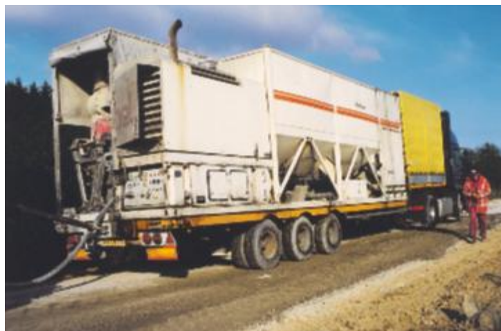
Een 'slurry-mixer' vermijdt stofvorming tijdens de werken.
