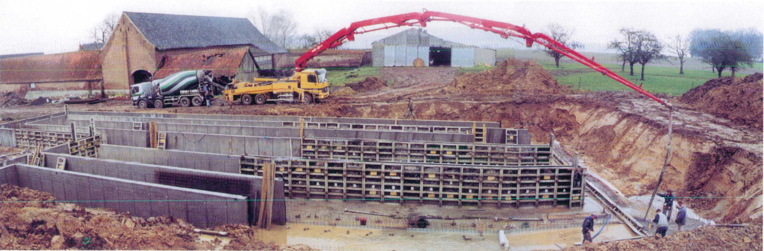
5- Gebruik van betonpomp voor de bouw van een mestkelder
