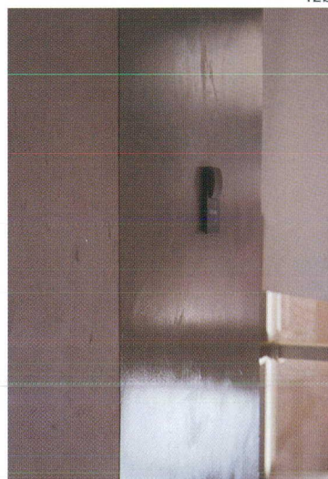
12. Invloed van contactbekisting. 12a. Ruw, mat oppervlak (gebruikte contactbekisting: planken). 12b. Glad, glanzend oppervlak (gebruikte contactbekisting: staal).
