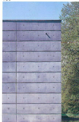
18a, 18b, 18c. In de gevel van het Wuidarhuis zijn de naden uitgewerkt als uitstekende voegen. 19. Profiellatten met schuine afkanting genieten de voorkeur.
