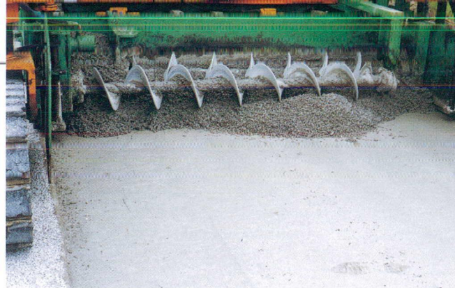
Uitspreiden van het zeer open beton 0/7
