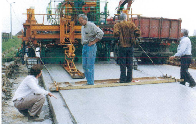
Aanleg toplaag in fijnkorrelig beton 0/7
