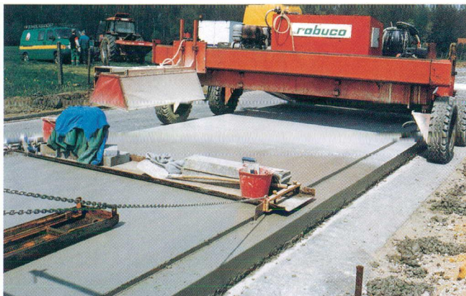
Aanbrengen van bindingsvertrager
