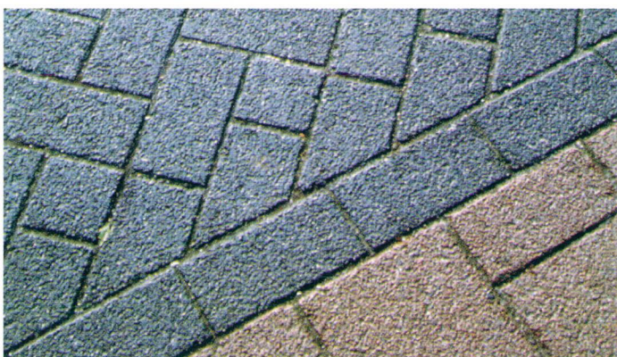
Geluidsarme betonstraatstenen gelegd in keperverband
