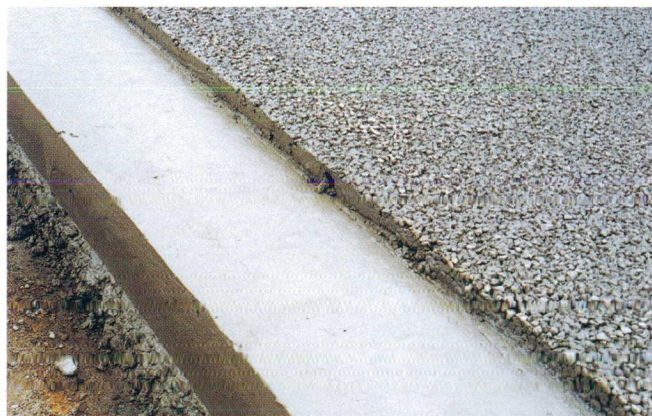
Detail toplaag (ZOB) en onderlaag
