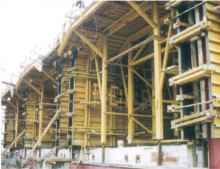
Bekisting van een tunnelement voor de Piet Heintunnel.
