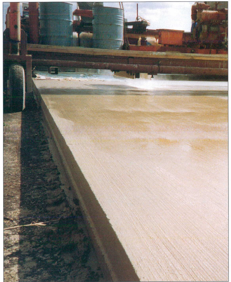
Curing compounds vormen een weerkaatsende film en beperken zodoende de verdamping.
