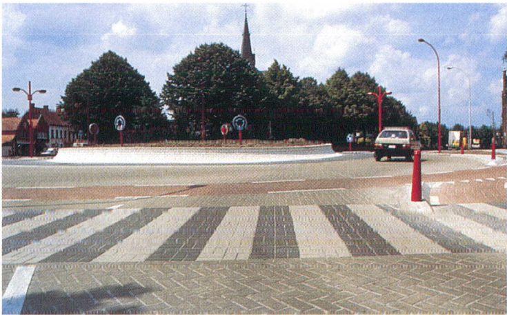
Rotonde integraal uitgevoerd in betonstraatstenen.
