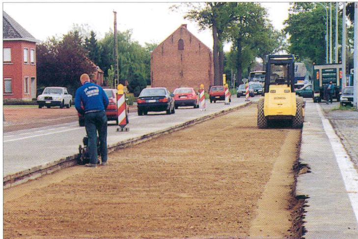
Walsbeton wordt aardvochtig verwerkt en intens verdicht
