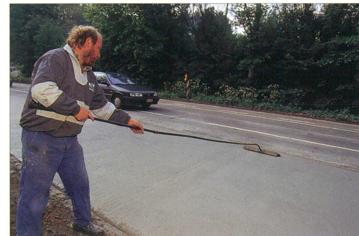
Bezemen van het betonoppervlak
