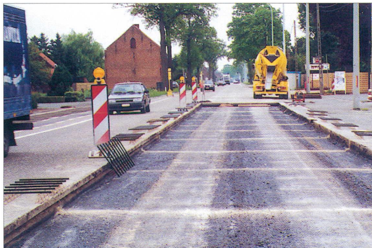
Voegen met een tussenafstand van max. 5 m
