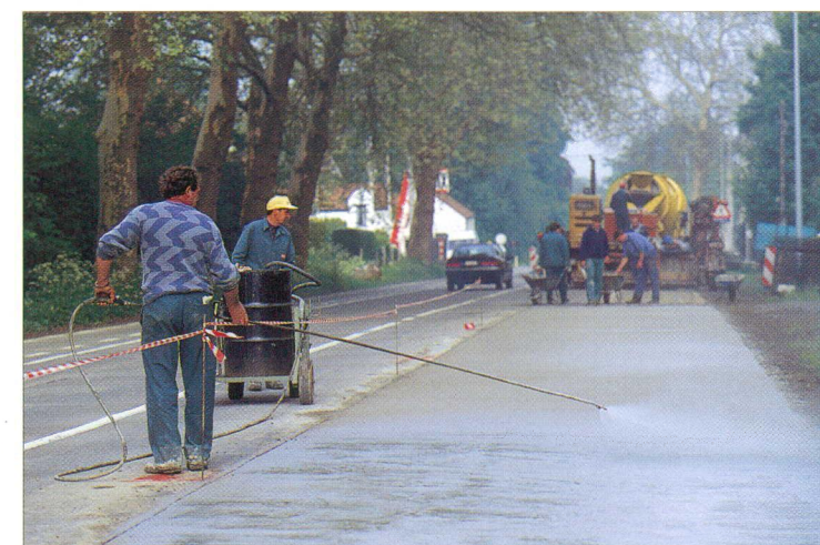
Aanbrengen van de curing compound
