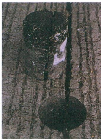
3 - Différence de niveau et fissure de coin causées par l'effet-curling
