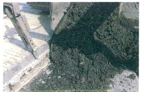
Répartition homogène des fibres dans le béton.
