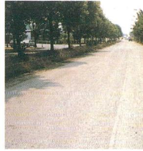
1a, b - Sur d'anciennes routes en béton l'interposition d'une couche bitumineuse est en fait inévitable. Le revêtement existant est éventuellement morcelé au préalable, afin de supprimer le mouvement des dalles. La dimension des fragments doit être inférieure à  $0,5 \text{ m}^2$ .
