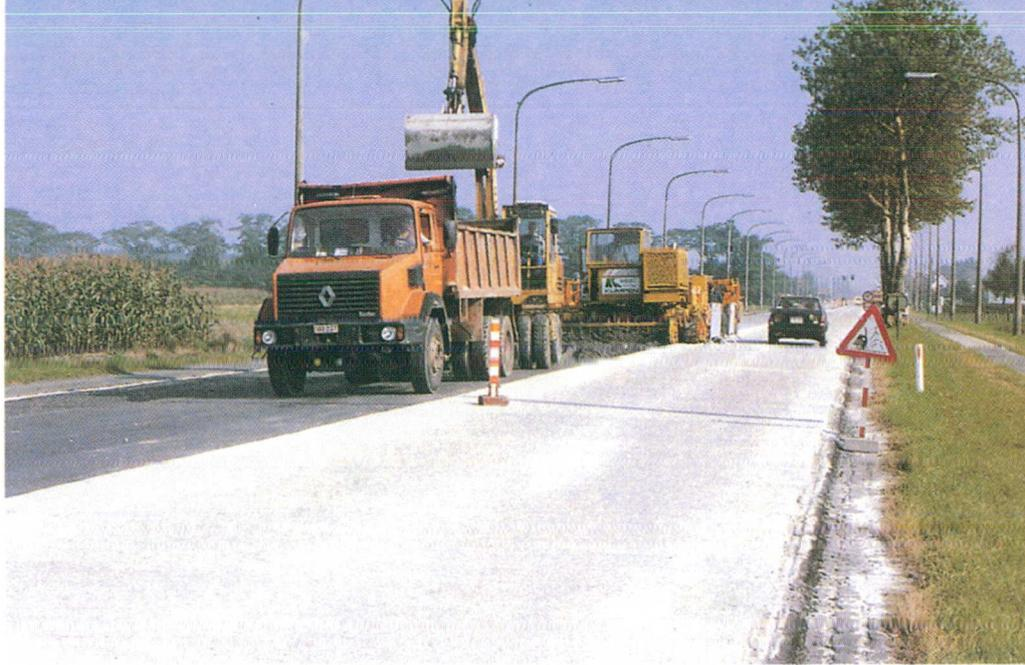
Exemple typique de chantier. Une moitié de la chaussée a été 'recouverte', et déjà ouverte à la circulation. Le béton est amené sur la bande de roulement encore à réaliser.
