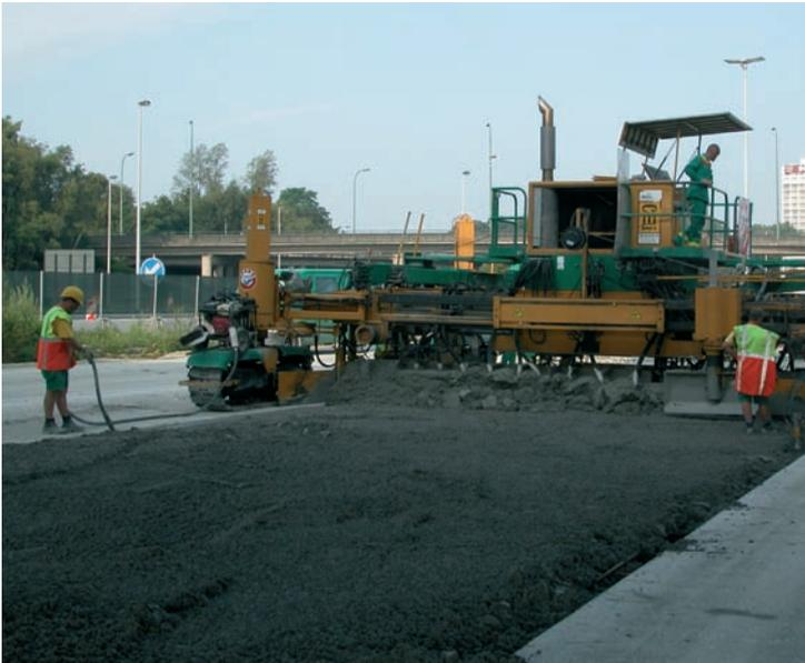
*Vue de la machine à coffrages glissants et de la vibration manuelle supplémentaire du béton le long des bords*
