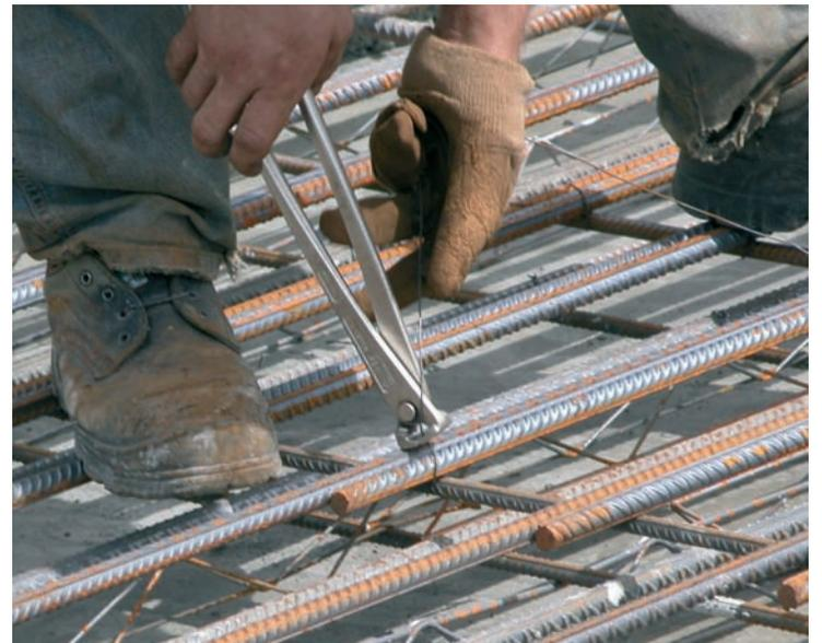
Pose de l'armature au-dessus de la culée d'ancrage
