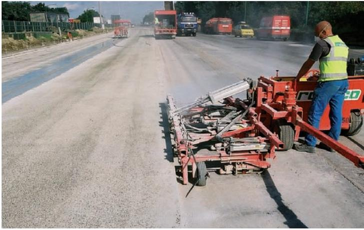
*Forage des trous pour les barres d'ancrage*
