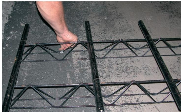
*Pose des goujons pour le revêtement en dalles de béton dans le tunnel Kennedy*
