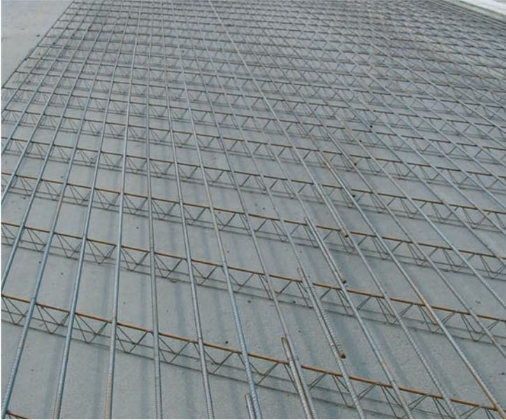
*Vue du recouvrement décalé des barres longitudinales*
