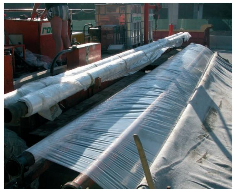
*Protection de la surface au moyen d'une membrane plastique*
