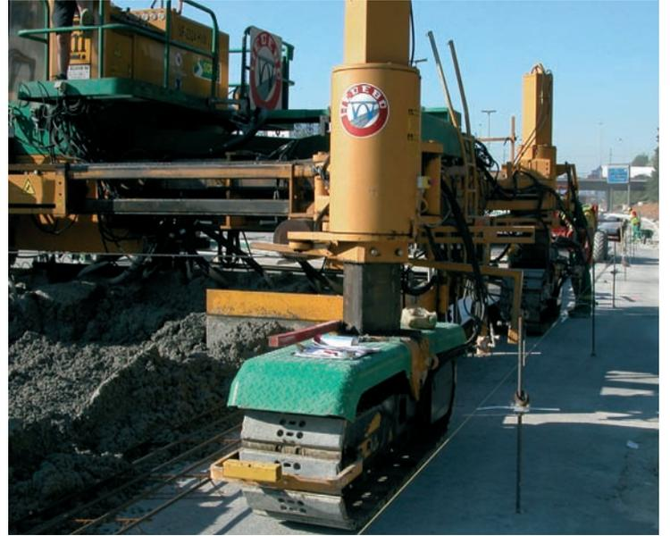
*La machine à coffrages glissants guidée sur fils*
