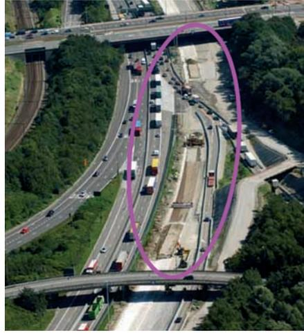
*Vue générale d'une interruption du BAC avec une couche de sable isolante aux extrémités*
