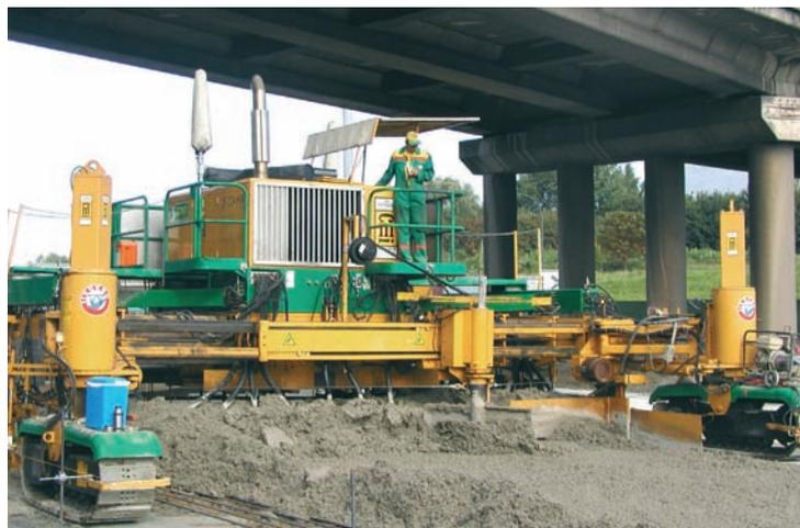
*Machine à coffrages glissants en action sur une largeur de pose de 7 m*
