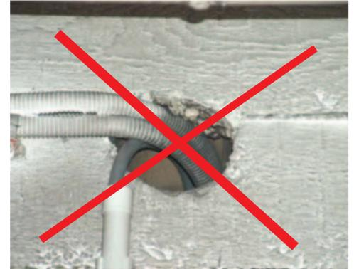
A proscrire ! Une ouverture dans une paroi EI laissant passer des câbles électriques et qui n'a pas été rejointoyée [22]
