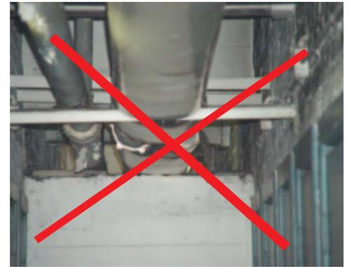
Mur non remaçoné dans une paroi EI, au niveau des canalisations de chauffage la transversant [22]
