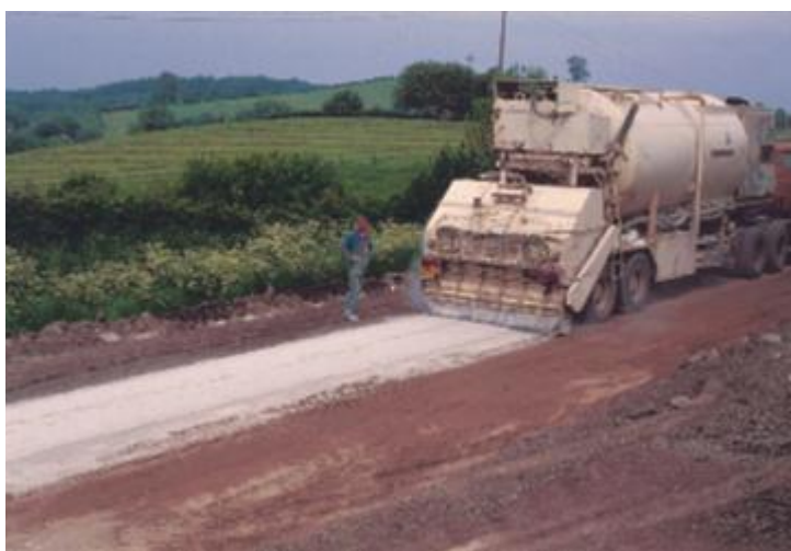
Les machines modernes épandent une quantité constante de liant par m 2 .
