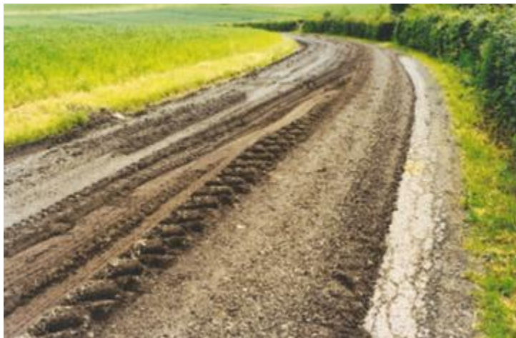
Une couche de matériau d'apport a été répandue sur la route existante.
