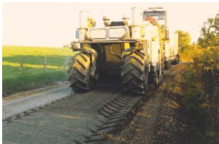
Les recycleuses sont des engins lourds capables de traiter en un passage une forte épaisseur.
