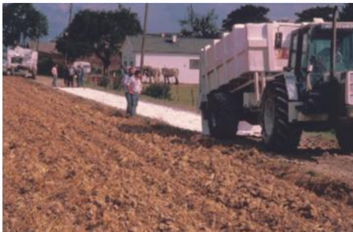
Les machines modernes épandent une quantité constante de liant par m 2 .
