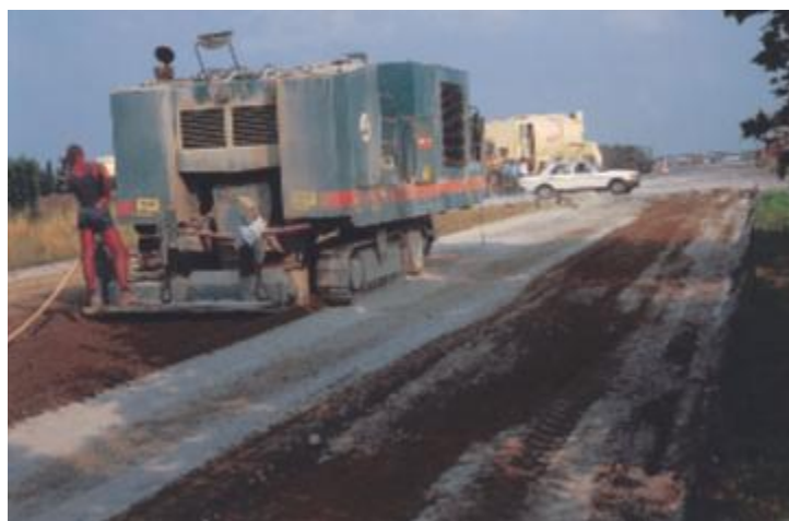
'Atelier de Reconditionnement de Chaussées' : le mélange se fait tant transversalement que longitudinalement.
