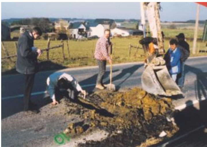
La tranchée d'échantillonnage s'étend sur une demi-chaussée...
