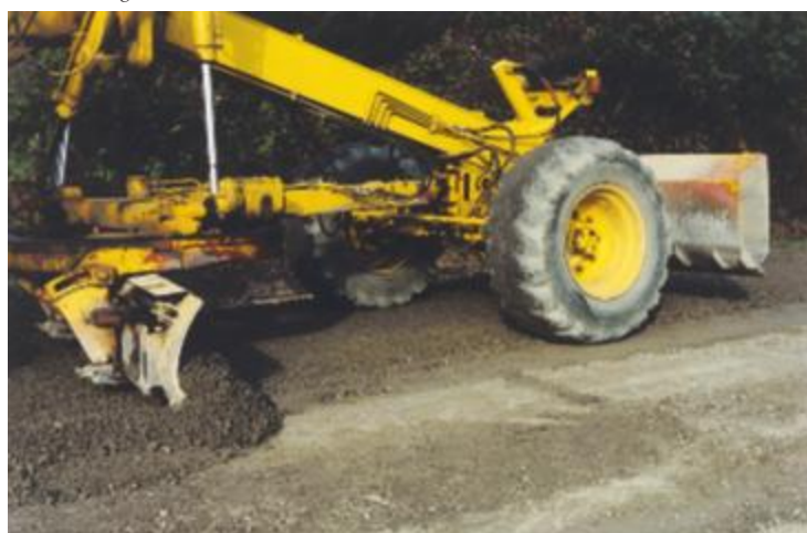
Nivellement grossier à la niveleuse.
