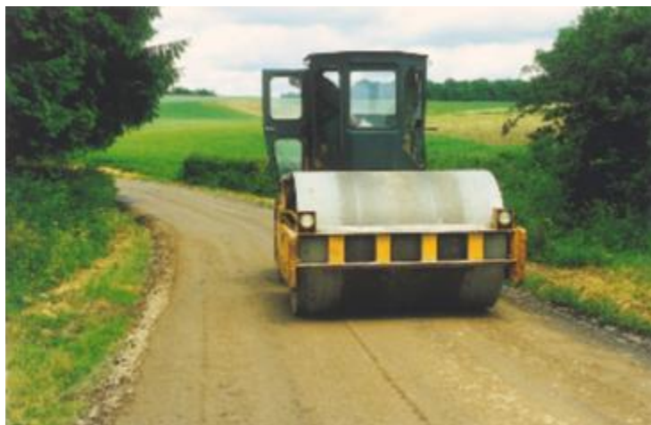
Les couches épaisses nécessitent un compactage supplémentaire au rouleau à pneus.
