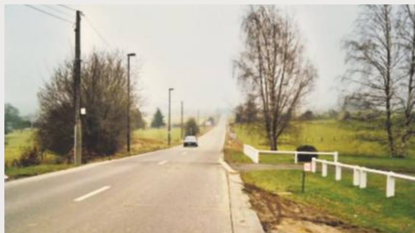
Exemple de chaussée après retraitement en place. Les routes principales peuvent aussi bénéficier de cette technique de rénovation.
