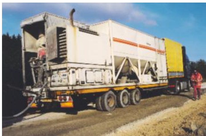
Le malaxeur de coulis permet d'éviter les poussières de ciment durant les travaux.
