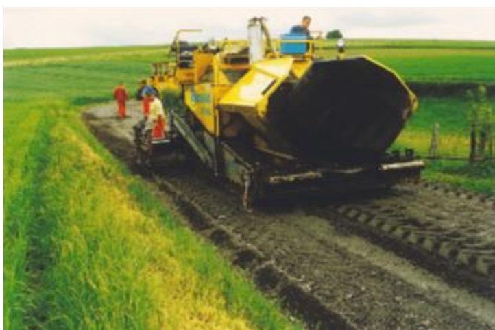
Le nivellement grossier peut être remplacé par une homogénéisation à la finisseuse.
