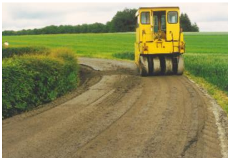
Les couches épaisses nécessitent un compactage supplémentaire au rouleau à pneus.
