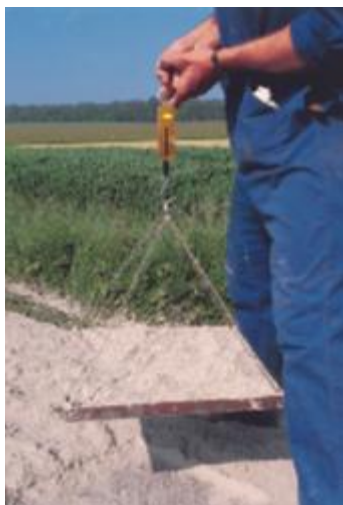
Contrôle de la quantité de ciment répandu.
