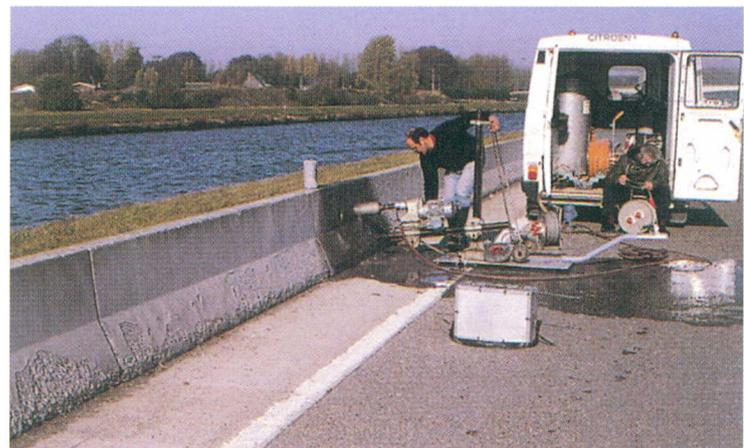
Action des sels de déverglaçage sur un séparateur en béton type "New Jersey" - Carottage pour analyses.
