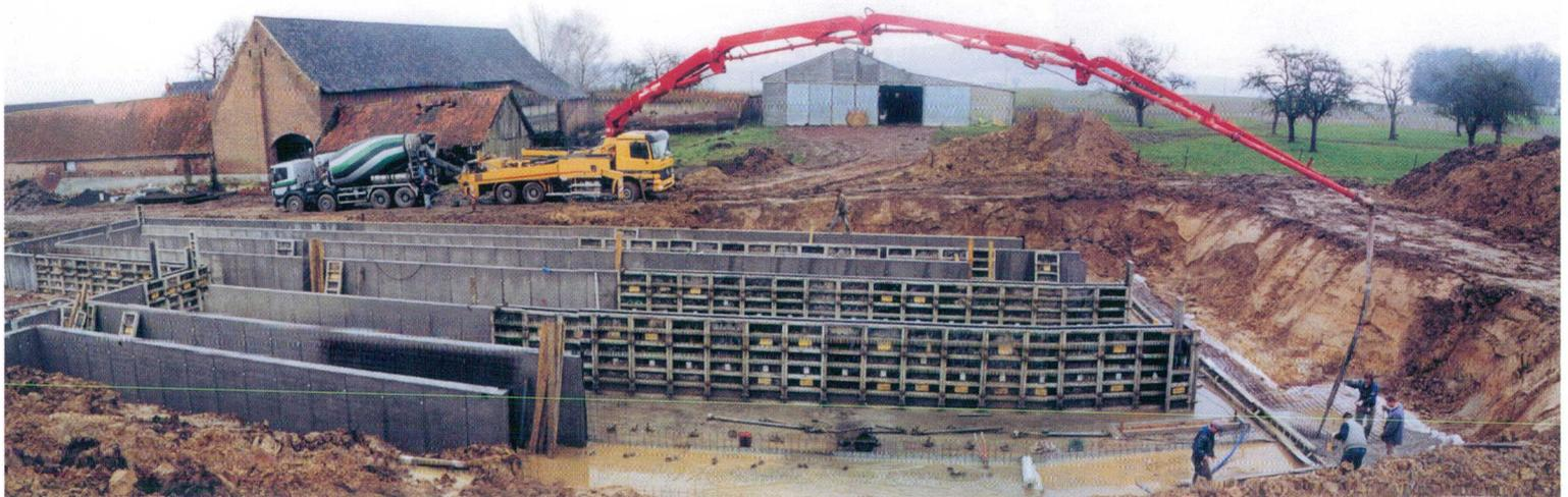
5- Utilisation d'une pompe à béton pour la construction d'une fosse à lisier
