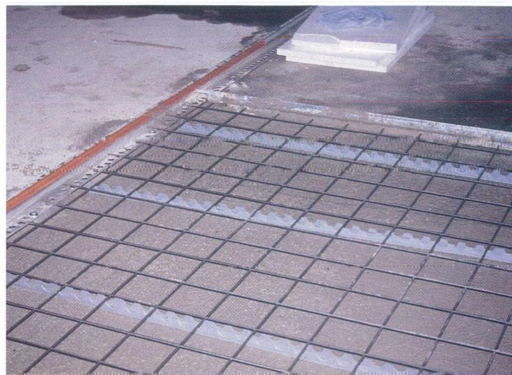
Treillis d'armature reposant sur des "peignes"
