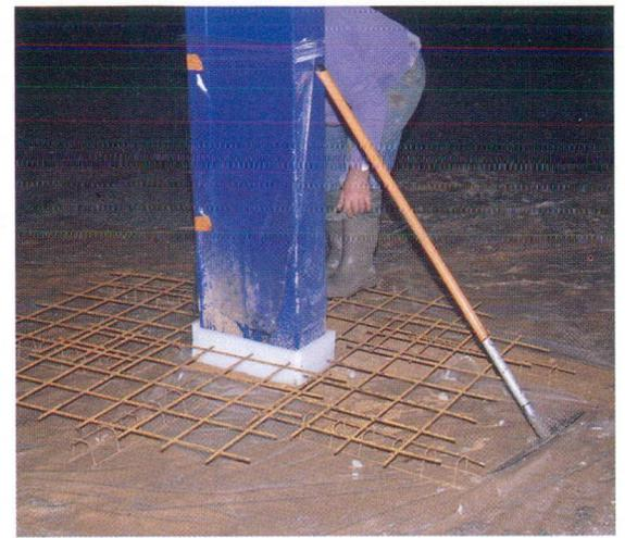
Bande compressible et armature locale pour joint de désolidarisation autour d'une colonne
