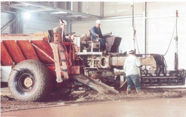
Déversement du béton au moyen d'un dumper
