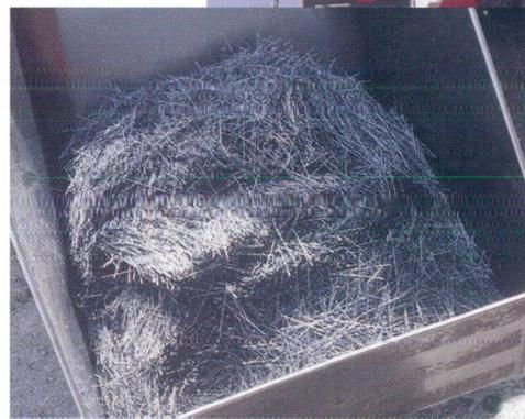
Intégration de fibres d'acier dans le camion malaxeur au moyen d'un vibro-éjecteur
