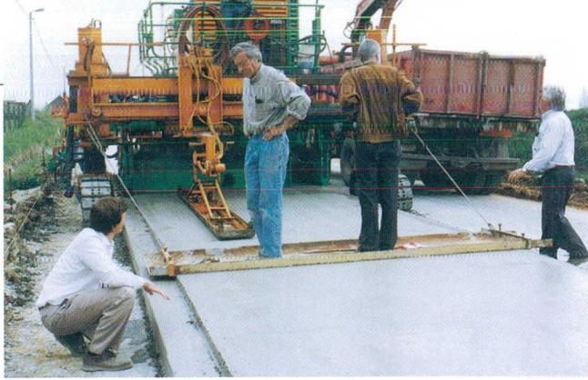
Réalisation de la couche supérieure en béton 0/7
