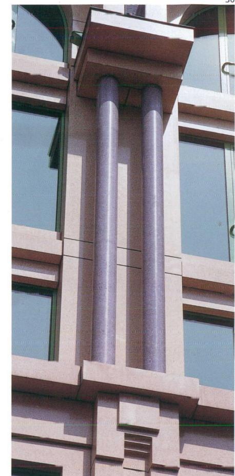
L'étage, conçu comme une loggia, met la structure en évidence en séparant la façade du toit, celui-ci reposant sur une structure de colonnes revêtues de panneaux de façade.
