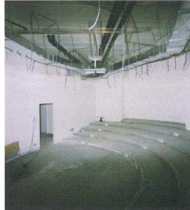
La construction du plancher de l'auditoire profilé en gradins est constituée de hourdis posés sur des murs en blocs de béton.
