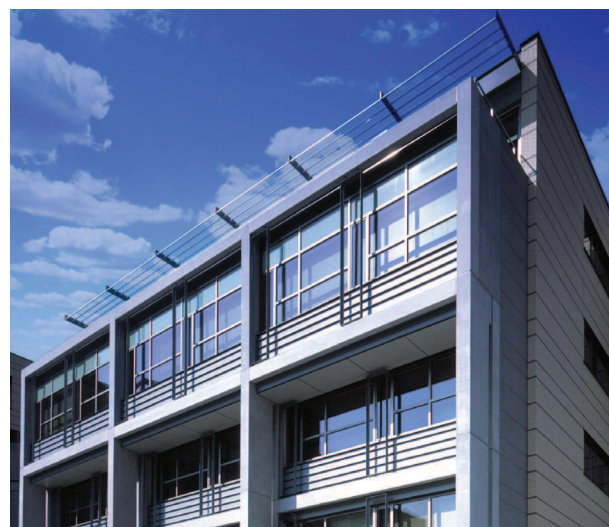
Gebouw Origin in Den Haag, (Beekink en Molenaar architecten)
