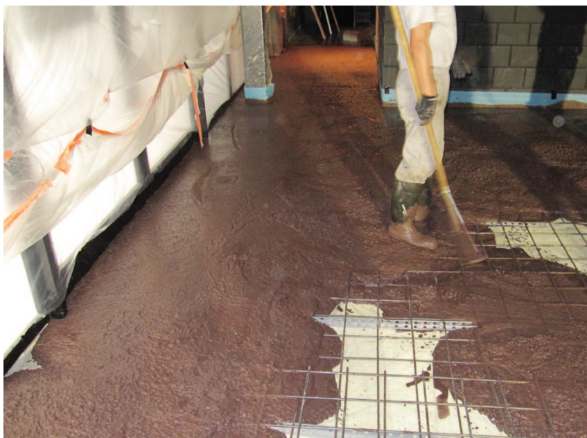
Vers beton met bruinachtige kleur door gebruik van een mengsel van 60 % anthraciet, 20 % geel en 20 % rood pigment. (Foto : Bart Helincks, Cathay)
