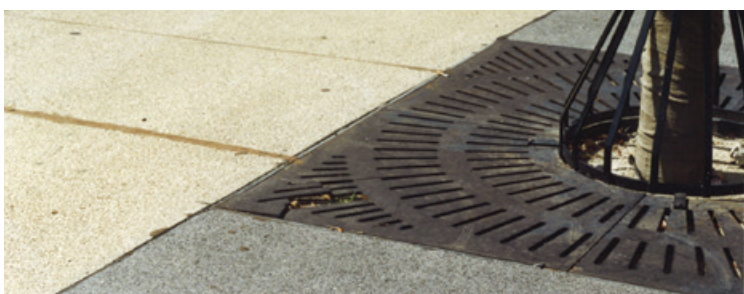
De combinatie van het gele en het zwarte beton
