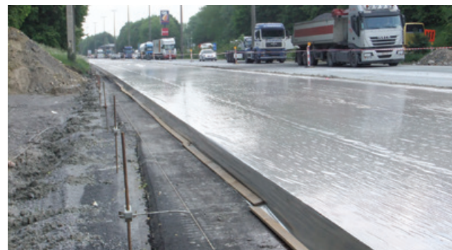
Het proces van 'chemisch' uitwassen van een betonoppervlak: sproeien van de bindingsvertrager op het verse beton – bescherming d.m.v. een plasticfolie – verwijderen van het bovenste mortellaagje met een borstelwagen
