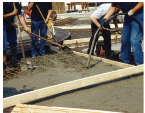
Verdichten van de onderlaag in grijs beton met trilnaalden
