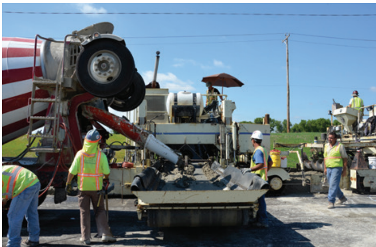
U.S. Tolweg I-90: bevoorrading van het beton voor de toplaag via een lopende band en oppervlakafwerking door fijngroeven in langse richting
