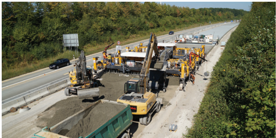
Duitsland, Würzburg, A7: het beton voor de bovenlaag wordt met een transportband over de eerste glijbekistingmachine tot op de onderlaag gebracht. (© Klaus Felsch, Heidelberg Cement)
