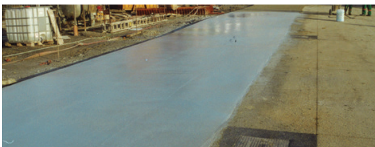
Op het pas aangelegde beton wordt de oppervlakbindingsvertrager gesproeid
