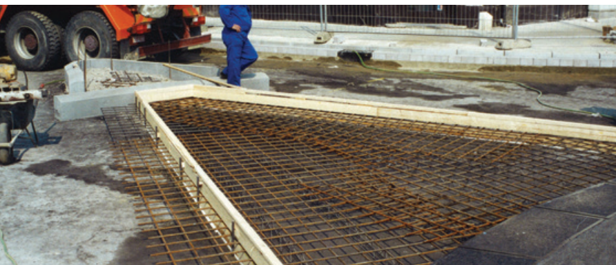
Houten bekisting en netwapening
