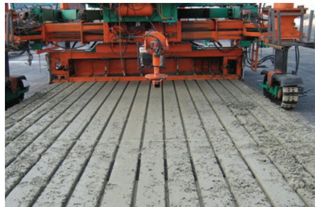
Lommel Kristalpark: plaatsen van deuvels in sleuven in de onderlaag
