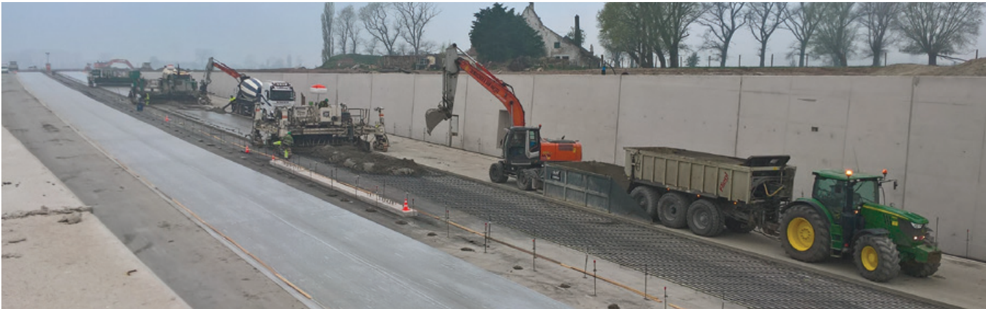
Aanleg in een open tunnelsectie (© Willemen)
