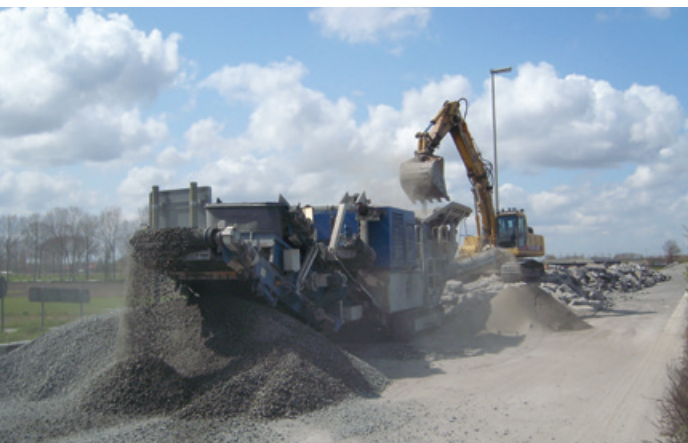
Het beton van de opgebroken oude betonverharding werd in een mobiele breek- en zeefinstallatie verwerkt tot nieuwe granulaten
