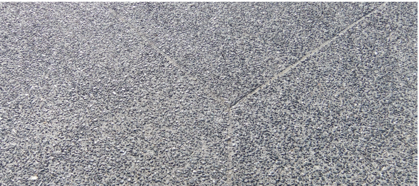
V.l.n.r.: storten en trillen van de onderlaag – afstrijken met de rei zonder verdichten van de toplaag – effenen van het oppervlak met een spaan – verstuiven van de oppervlakbindingsvertrager. Foto onder: afgewerkt uitgewassen oppervlak.
