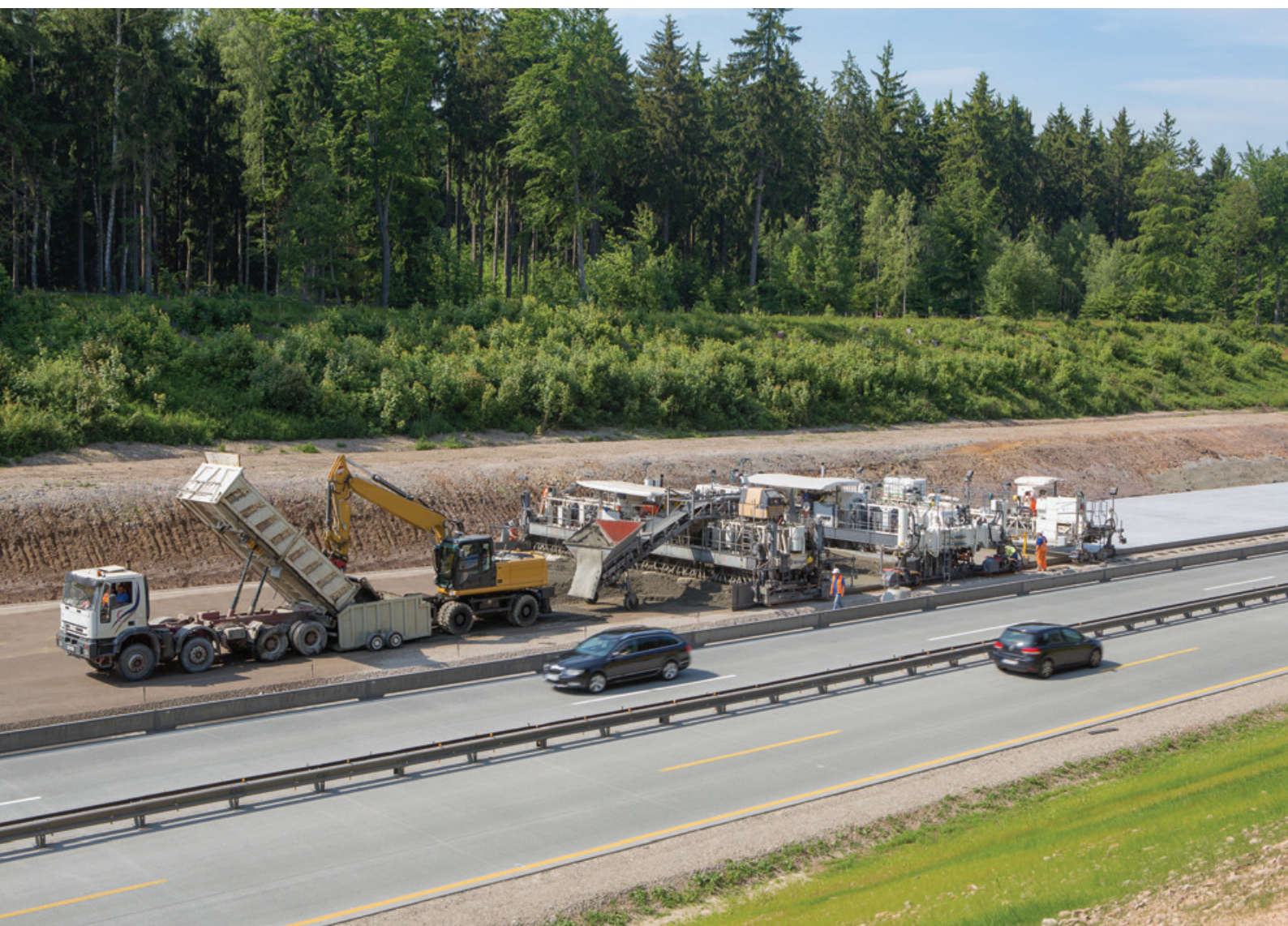
Tweelaagse uitvoering met twee geïntegreerde glijbekistingmachines (© Wirtgen)
