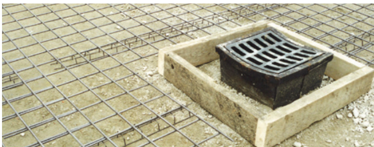
Bekisting voor het manueel te storten zwart beton rond de waterslokkers
