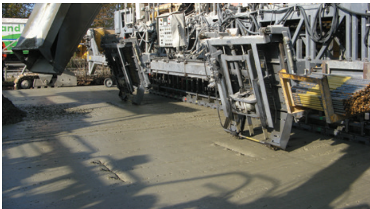
Duitsland, Trier: deuvels en ankerstaven worden ingetrild in de onderlaag (© Klaus Felsch, Heidelberg Cement)
