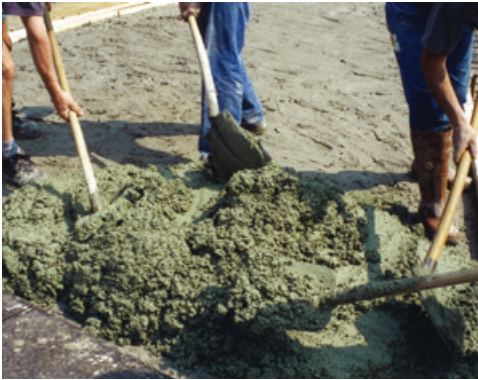
Uitspreiden van groenkleurig beton van de toplaag.
