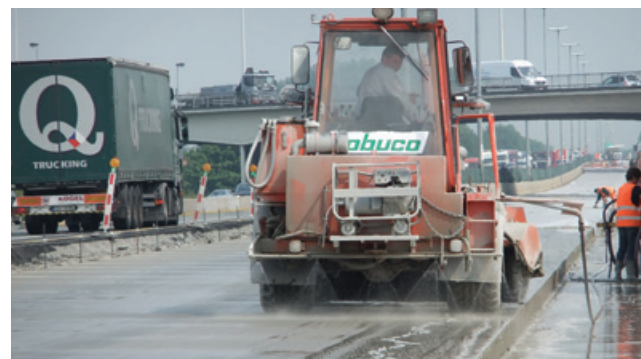
Het proces van 'chemisch' uitwassen van een betonoppervlak: sproeien van de bindingsvertrager op het verse beton – bescherming d.m.v. een plasticfolie – verwijderen van het bovenste mortellaagje met een borstelwagen
