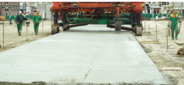
Betonnieren van onderlaag en toplaag
