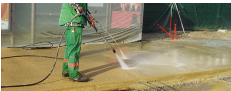
Het uitwassen van het oppervlak gebeurt door middel van hogedrukreinigers
