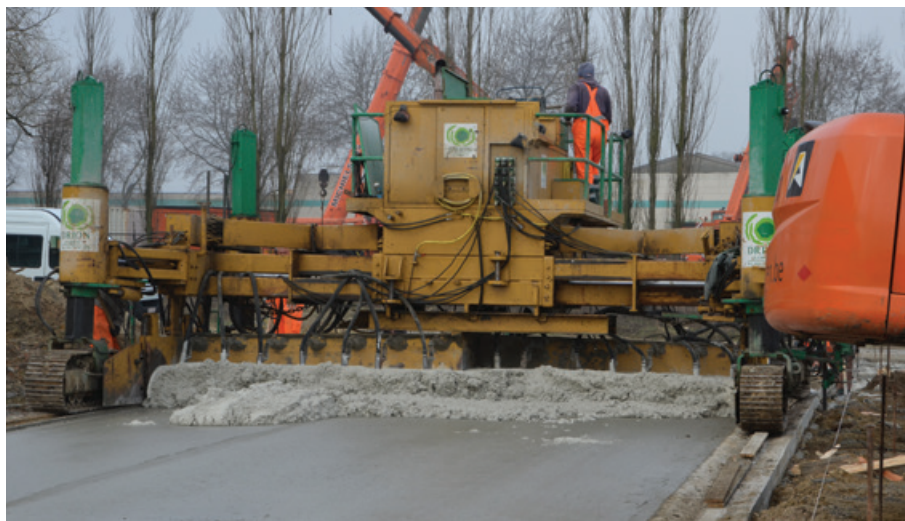
Aanleg van de witte toplaag met titaandioxide van het tweelaags beton te Wijnegem
