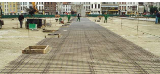
Plaatsen van de wapeningsnetten in de onderlaag
