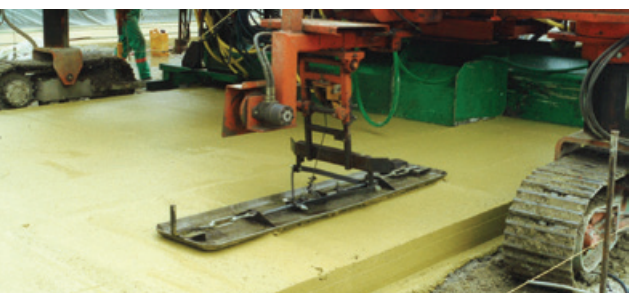
De 'supersmoother' of langse afstrijkalk werkt oneffenheden weg in het vers aangelegde beton van de toplaag
