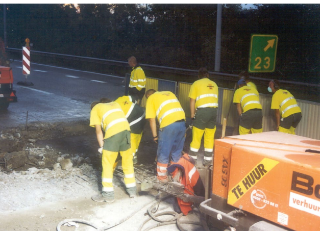
Manuele opbraak in de zone van de behouden wapening
