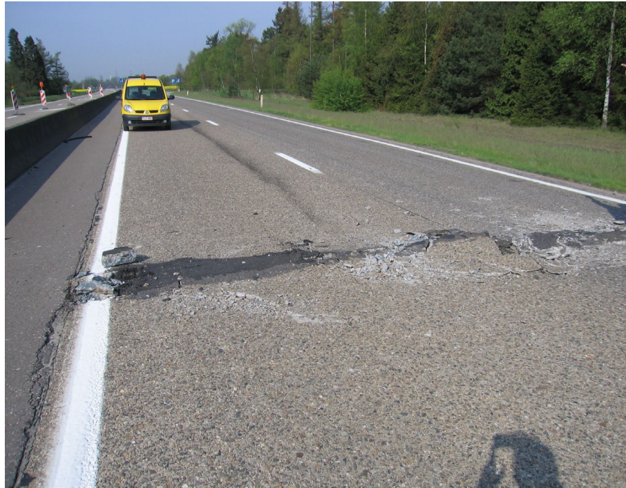
Mol, N71, opstuiking ter hoogte van een voorlopige herstelling van een dwarse werkvoeg met asfalt (Foto: AWV)
