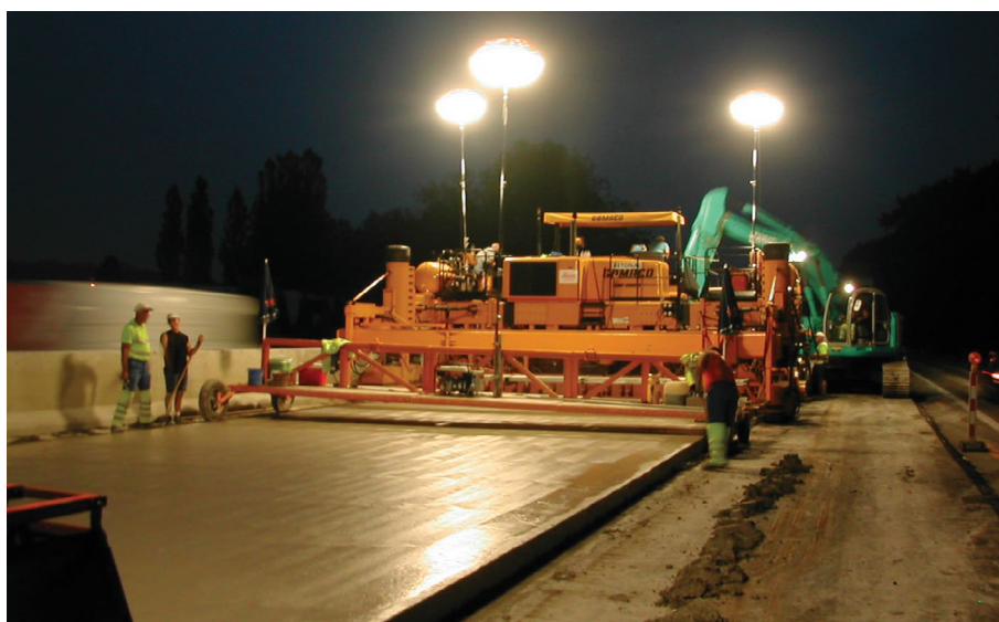
2003, A10, Groot-Bijgaarden, continu betonneren, dag en nacht
