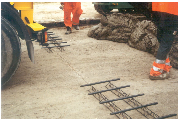
Herstellen van platenbeton – gedeuvelde dwarse krimpbuigvoeg (in uitvoering) op een fundering van gezaagd walsbeton
