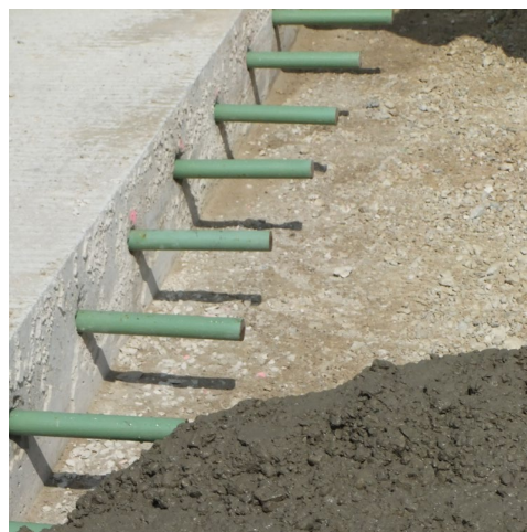
Gedeuvelde dwarse werkvoeg
