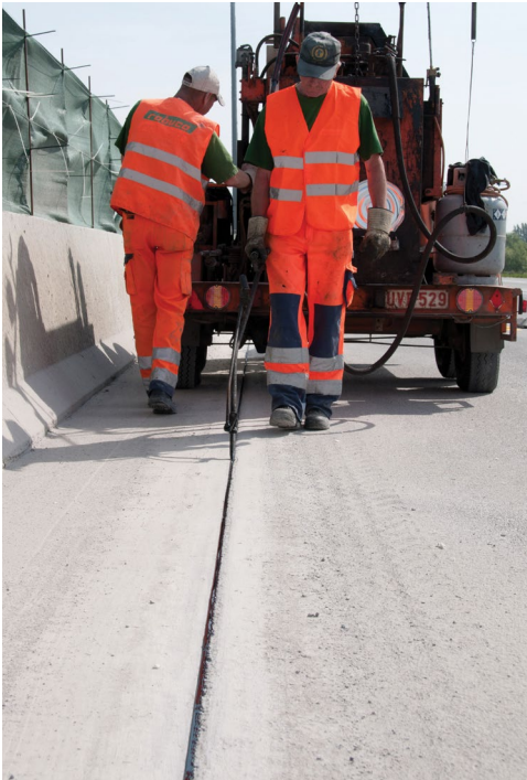
Aanbrengen van warme voegvullingsmassa in een langsvog
