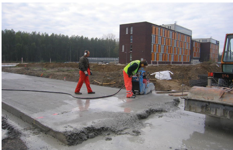
Afzagen en verwijderen van het laatst gestorte gedeelte van een weg in platenbeton
