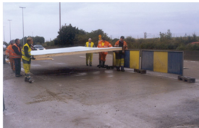
Aanbrengen van isolatieplaten op het herstelbeton met het oog op het behoud van de hydratatiewarmte en een snellere uitharding
