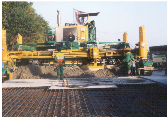
Panelen op het DGB om te vermijden dat vers beton achter de dwarse werkvoeg terecht komt
