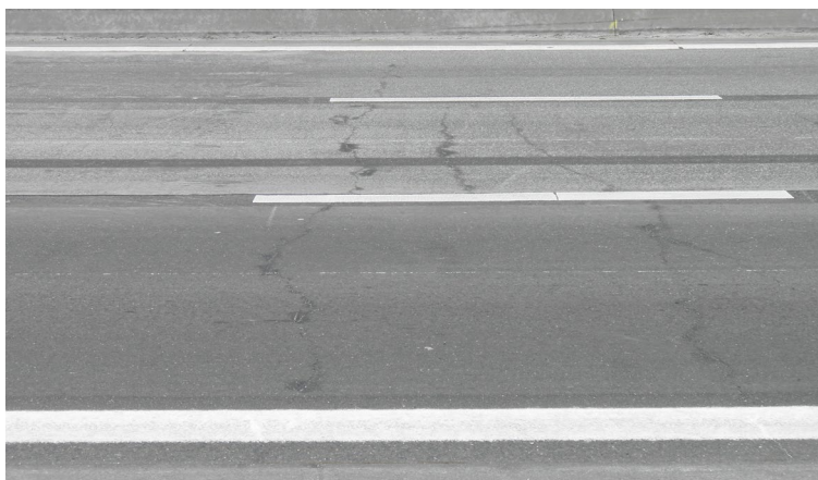
E40/A10, Affligem, DGB, zicht op grillig scheurpatroon
