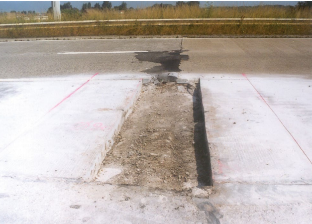
Te herstellen vak met zaagsneden op volledige en halve dikte
