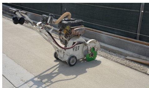
E313, Herentals, realisatie van de scheuraanzetten in DGB
