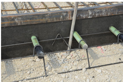
Deuvels in een dwarse uitzettingsvoeg
