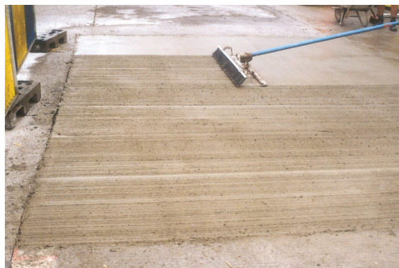
Oppervlakafwerking door dwars bezemen
