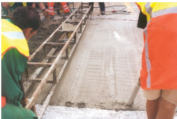
Verdichting met dubbele trilbalk en trilnaald aan de randen
