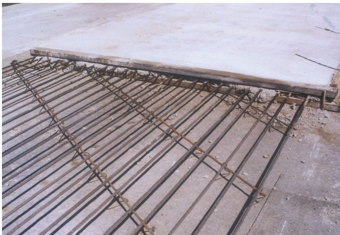
Dwarse werkvoeg in DGB (met aandacht voor de verticaliteit van de voeg)
