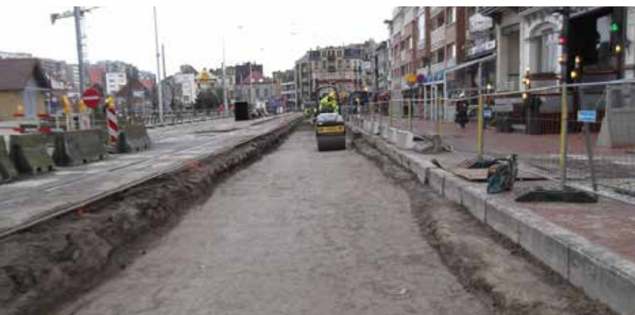
Blankenberge - Aanleg van een fundering in walsbeton (Foto: Tractebel)
