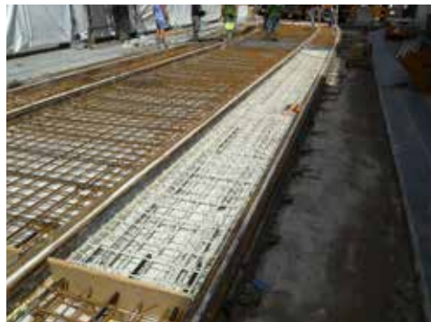
Zone met glasvezelwapening om interferentie met besturingssignalen te voorkomen (Foto: OCW)
