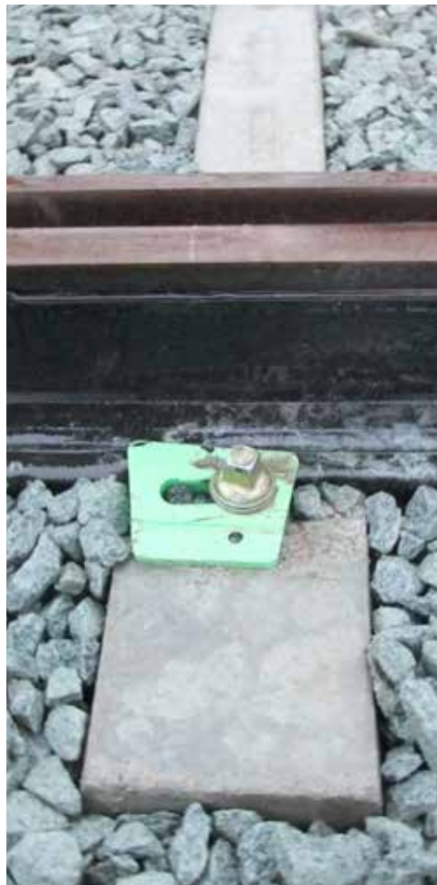
Omhulling van de rails met trillingsdempend materiaal
