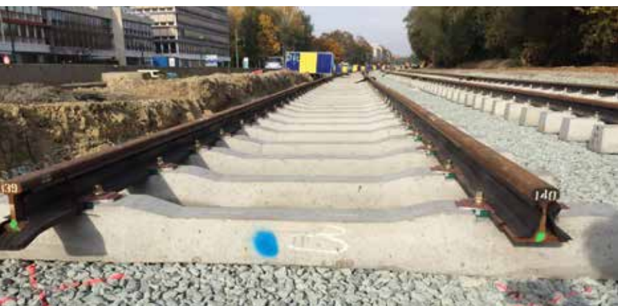
Brussel – voorbeeld van fundering in ongebonden steenslag met daarop de betonnen dwarsliggers, die nadien worden vastgezet door het tussenstorten van beton (Foto : AB-Roads)
