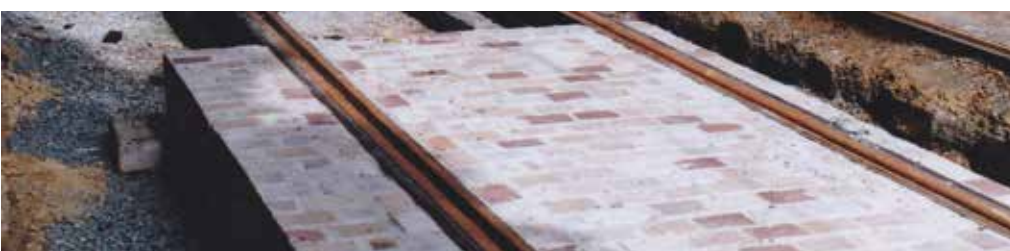
Geprefabriceerde betonnen spoorplaat met ingewerkte natuursteen kasseien
