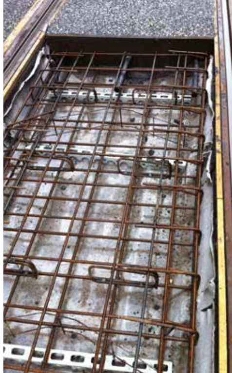
Zicht op de langswapening en dwarse beugels van het bovenbeton (Foto: OCW)
