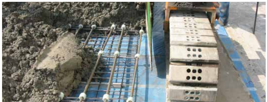
Gent, Voskenslaan - Plaatsen van onderlaag in DGB op trillingsremmende mat (dit resulteerde in ongewenste verplaatsingen van de structuur waardoor de voorkeur voor trillingsdemping uitgaat naar een isolerende omhulling van de rails) (Foto: Tractebel)
