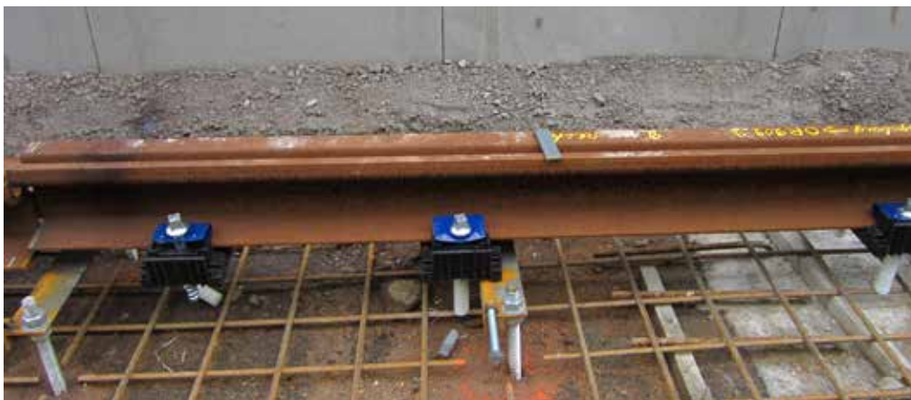
Rails die met draadstangen en stelschroeven gemonteerd zijn op de fundering. Het onderbeton zal er onder gestort worden (Foto: De Lijn)
