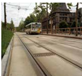
Antwerpen, De Leien - zicht op de trambusbaan - detail uitzettingsvoeg tussen lange gewapende platen
