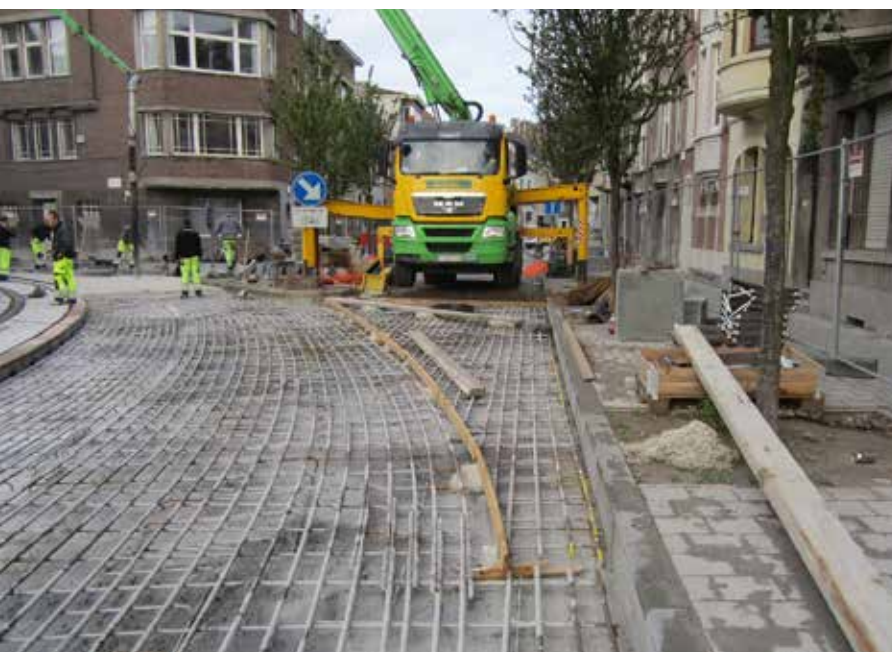
Betonneren van de bovenlaag volgens het patroon van langsvoegen en zicht op de realisatie (Foto's: De Lijn en AB-Roads)
