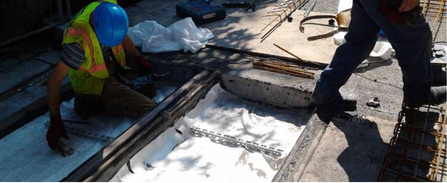
Antwerpen, Nationalestraat – Geotextiel tussen onderbeton en bovenbeton (Foto: OCW)
