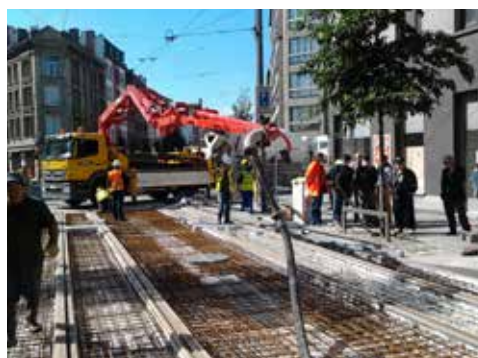
Aanvoer van het beton door pompen (Foto: OCW)
