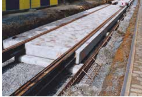
Brussel – toepassing van prefab spoorelementen : langse railliggers te Laken, prefab spoorplaten te Anderlecht
