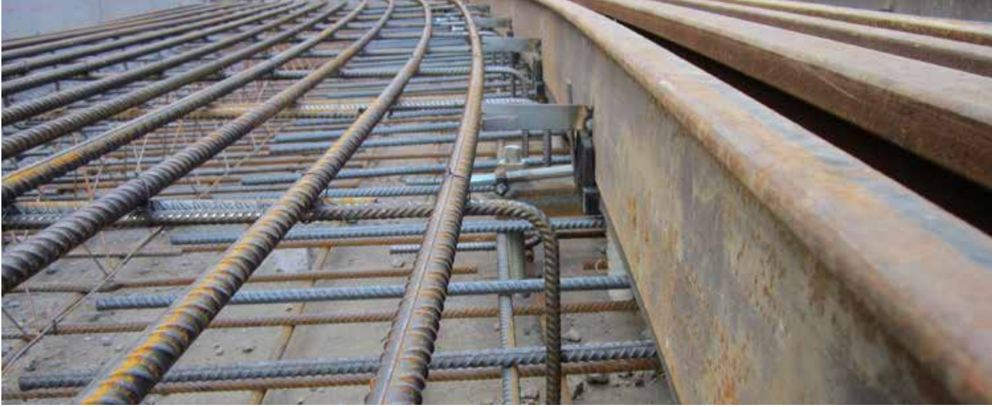
De beugels die de langswapening ondersteunen dienen tevens als solidaire verbinding tussen onderbeton en bovenbeton (Foto: De Lijn)
