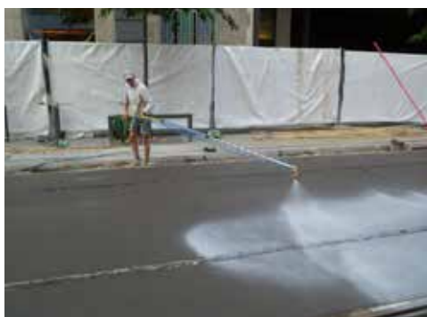
Aanbrengen van een bindingsvertrager op het oppervlak (Foto: OCW)
