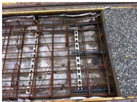
Dwarse gedevelde uitzetvoeg (Foto: OCW)
