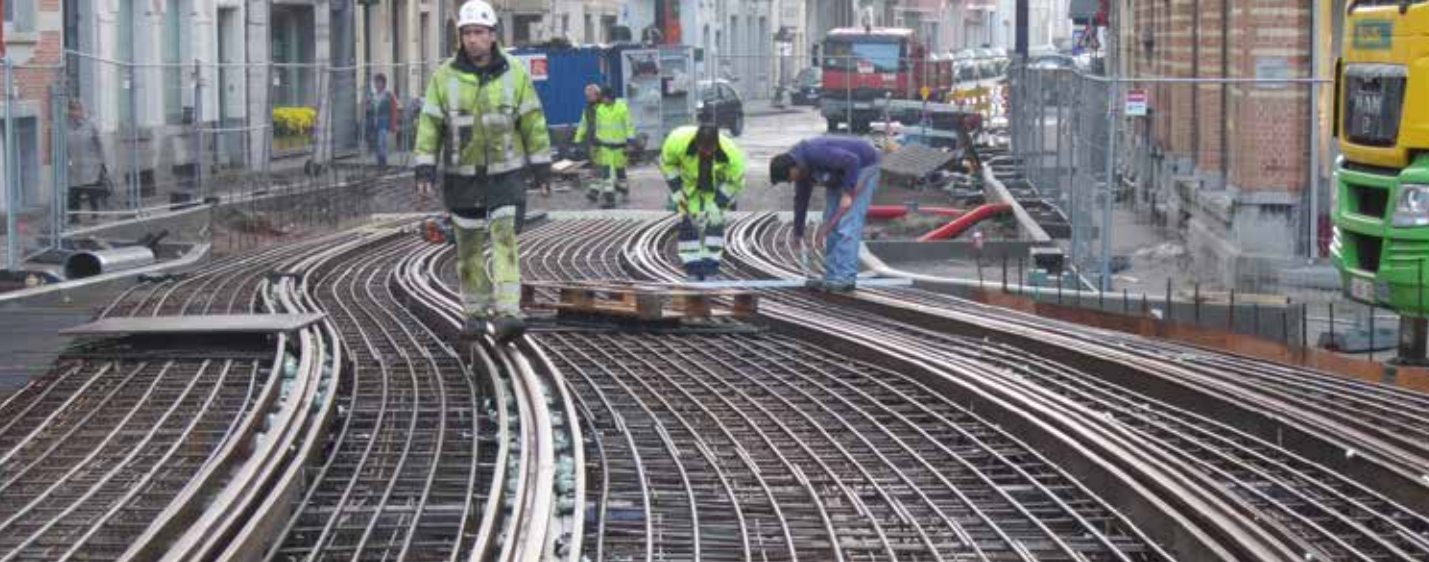
Zicht op het geheel van de wapening van boven- en onderbeton (Foto: De Lijn)
