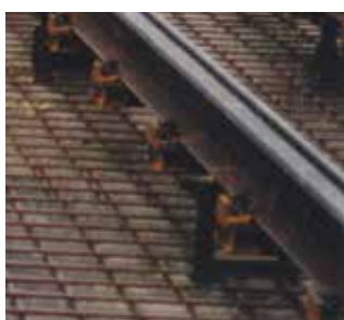
Hoboken, Sint-Bernardsesteenweg v.l.n.r.: rails, gesteld op de asfalt tussenlaag - zicht op de wapening – verdichting van het onderbeton
