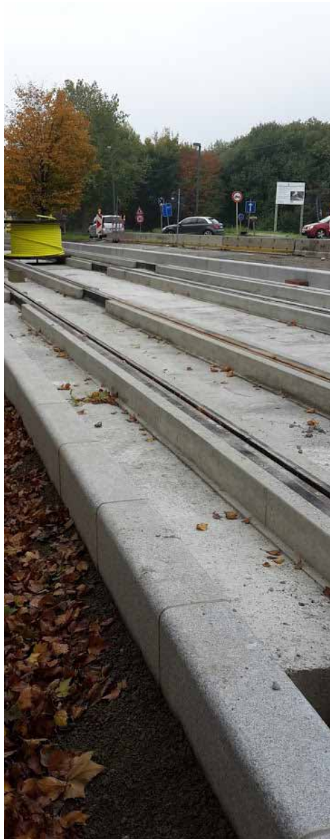
Brussel : systeem met ingestorte railliggers, rustend op dwarse liggers (Foto's : AB-Roads).
