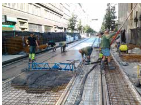
Aanleg van het bovenbeton met de trilbalk (Foto: OCW)
