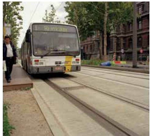
Antwerpen, De Leien – Dwars gebezemde afwerking
