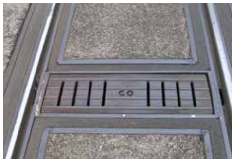
Gent, Korte Meer en Mortsel, Liersesteenweg –ingewerkte spoorwissel, spoorafwatering en andere accessoires vragen om specifieke detaillering in ontwerp en uitvoering. Ter hoogte van de wissels worden scherpe punten in het beton vermeden door een driehoekige metalen inlegplaat te voorzien.
