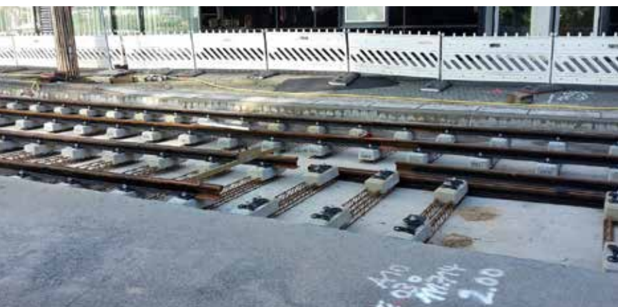
Een alternatief voor de klassieke betonnen dwarsliggers zijn de zogenoemde "bi-bloc" liggers, bestaande uit twee betonnen steunblokken, verbonden door een stalen vakwerkligger. (Foto : AB-Roads)
