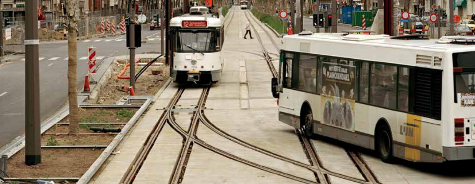
Antwerpen, De Leien - Gecombineerde trambusbaan
