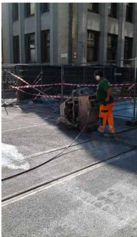
Zagen van de dwarse voegen (Foto: OCW)
