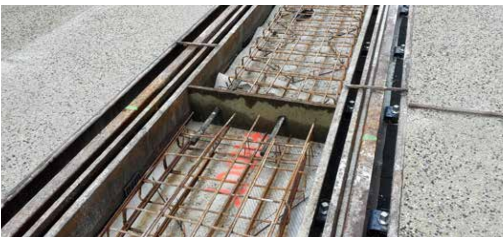
Onder- en bovenbeton zijn hier gescheiden door een geotextiel. De bovenplaat is in dat geval dubbel gewapend (Foto: AB-Roads)
