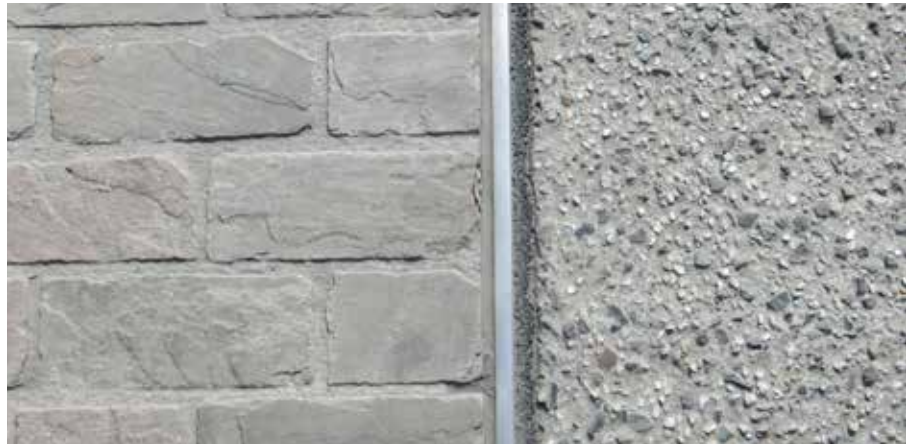
Gent, Korenmarkt – Uitgewassen beton op basis van witte kwarts en zandsteen, in harmonie met naastliggende natuursteen kasseien
