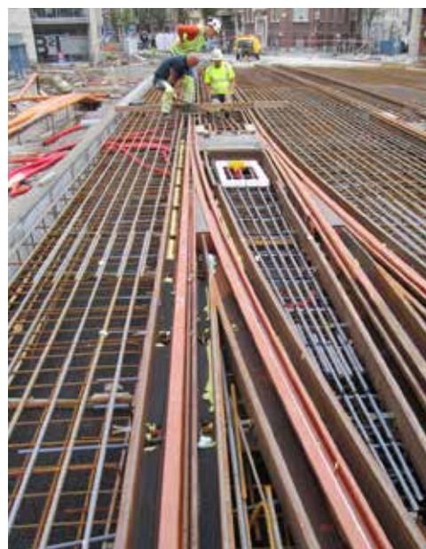
Zicht op de detailwapening ter hoogte van wissels (Foto: De Lijn)
