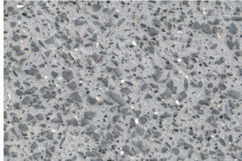
*Exemple de carrefour en béton lavé noir à Tremelo. La couleur noire a été obtenue principalement par l'utilisation de concassé noir, en l'occurrence du basalte, additionné d'une petite fraction de pyrite brillante (laitier de silicate d'aluminium noir foncé). Le mortier anthracite a été obtenu par l'addition de 4 % de colorant noir au béton.*
