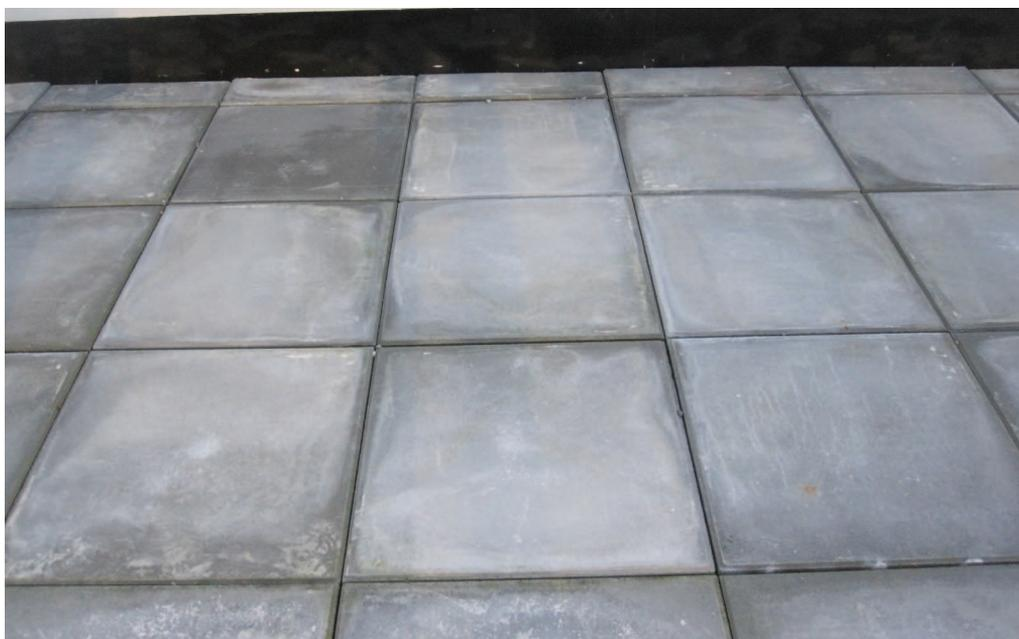
Parfois, le phénomène d'exsudation de chaux peut être évité par la fabrication d'un béton bien fermé (faible facteur eau/ciment, bonne compaction et cure). Il est important de protéger le béton qui vient d'être coulé ou les produits décoffrés de la pluie et de la neige. Si le phénomène se produit néanmoins, on peut dans certains cas procéder à un nettoyage au moyen d'une solution d'acide chlorhydrique (HCl, 1 à 3%) diluée à l'eau.
