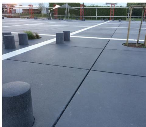
*Revêtement d'une place à Redu au moyen de dalles de béton préfabriquées à finition acidée, combinées à des bandes blanches en béton*
