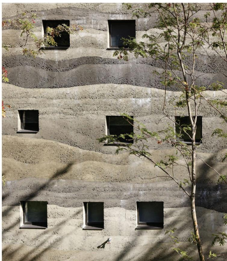
La réaction du ciment et de l'eau forme des produits d'hydratation. Sur le plan microscopique, on peut les présenter de manière simplifiée comme des aiguilles de cristal. Les grains de pigment, environ 20 x plus petits que ceux du ciment, vont se nicher physiquement entre ces pointes.
