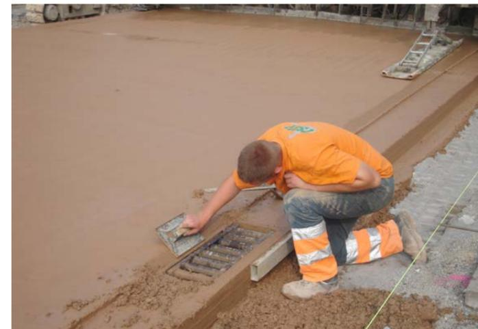
Les bétons colorés sont généralement obtenus par l'ajout d'un pigment sous forme de poudre. Ces colorants sont très fins (grains moyens de l'ordre de  $0,2$  à  $1 \mu\text{m}$ ) et ont donc une demande en eau élevée. Il est important pour conserver les caractéristiques de durabilité du béton aux cycles de gel-dégel de ne pas augmenter la teneur en eau du mélange mais de compenser la perte d'ouvrabilité éventuelle par l'ajout d'un plastifiant.
