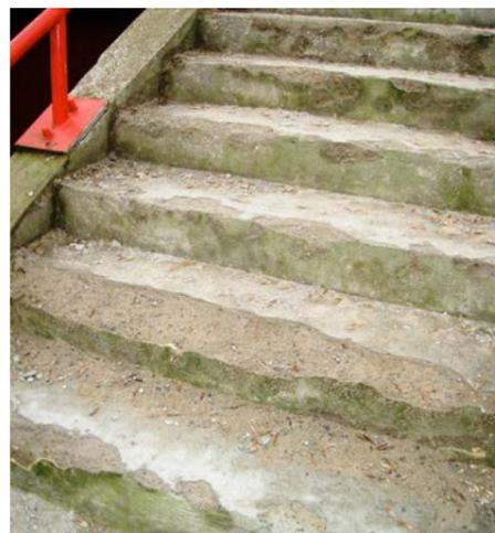
Les parties d'ouvrages dont le béton présente le plus fort degré de saturation se dégradent le plus fort : elles correspondent soit à des parties qui fonctionnellement sont au contact de l'eau, soit à des parties qui par leur géométrie retiennent préférentiellement les eaux de précipitation (surfaces horizontales).
