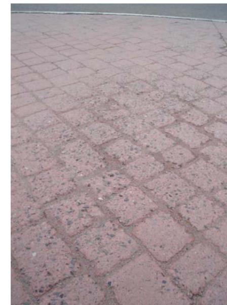
Ecaillage à la surface d'un revêtement en béton imprimé exposé à des sels de déverglage
