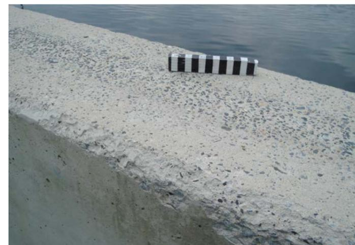
Dégâts de gel avec sels de déverglaçage sur le haut du voile d'un bassin de décantation d'une station d'épuration. La partie supérieure des voiles verticaux est particulièrement vulnérable en cas de remontée trop importante de mortier et de laitance. Il peut s'avérer utile de les enlever par brossage ou de les enrichir par saupoudrage d'un mélange sec (1 part de ciment – 1 part de sable) suivi d'un talochage vigoureux, mécanique ou manuel.
