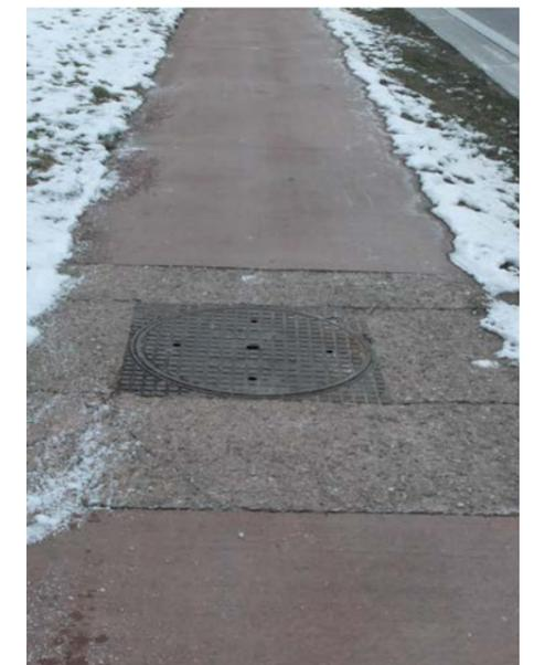
Piste cyclable réalisée en 2001, toujours en très bon état, à l'exception de la zone autour de la chambre d'inspection. La dégradation est due à une mauvaise composition du béton.
