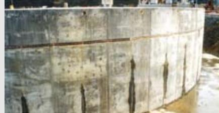
Fig. 13 – Fissures de retrait thermique empêché (bridage) dans un voile en béton. Le radier en béton préalablement bétonné entrave les déformations du béton lors de la contraction thermique.
