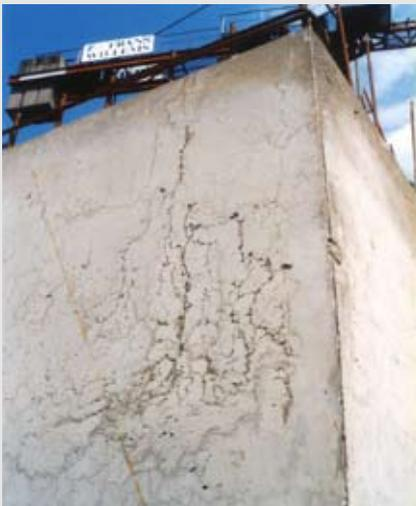
Le phénomène de ressuage à la surface du béton est bien connu. Mais il en est d'autres tels que la migration vers le haut d'eau entre le béton et le coffrage. Dans cet exemple, l'eau remonte en se rassemblant en petits ruissellements et en entraînant des fines en surface.
