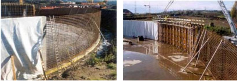
Fig. 7a,b – Voile en béton protégé par une toile après décoffrage
