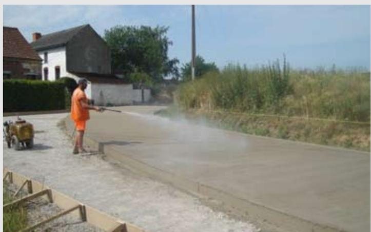
Pulvérisation d'un produit de cure à la surface d'un béton routier fraîchement mis en œuvre.
