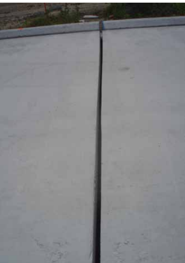
Ouverture scieée pour placer le joint de dilatation
