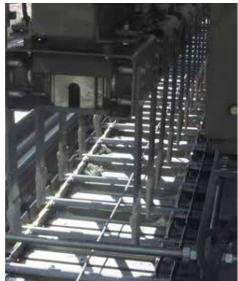
Enfoncement de goudjons par vibration dans le béton frais
