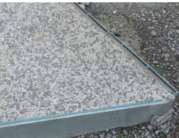
Profilé en acier galvanisé fabriqué sur mesure, joint de construction (Herstal, Pôle Marexhe)
