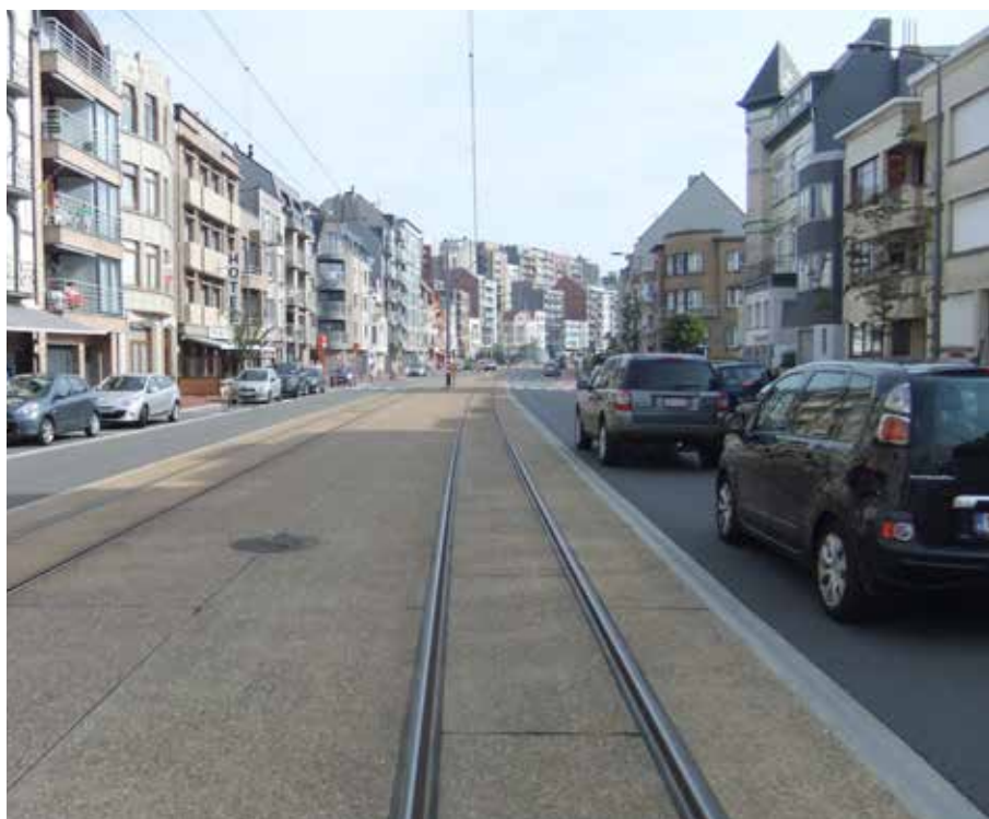
Voie de tram à Blankenberge avec des dalles en béton étroites entre les rails et le long de ceux-ci
