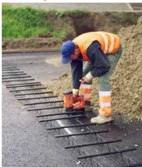
Fixation des goudjons sur une couche de liaison en asphalte
