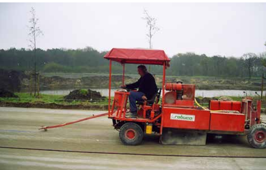
Dispositif de sciage du joint de flexion longitudinal
