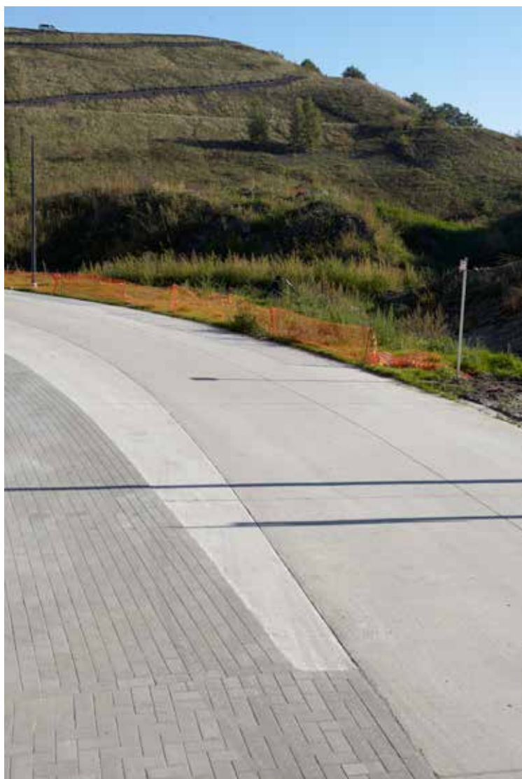
Nouvelle route en dalles de béton, avec bande de parking. Remarquer la surlargeur de la route dans le virage. © A. Nullens
