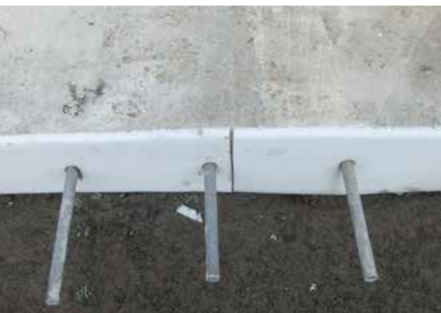
Joint de dilatation transversal goujonné
