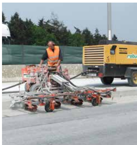
Forage des trous pour les barres d'ancrage
