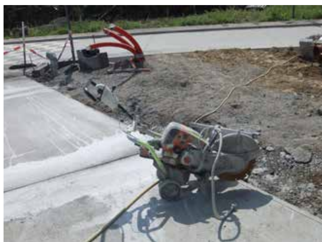
Le sciage des joints nécessite un matériel professionnel adapté
