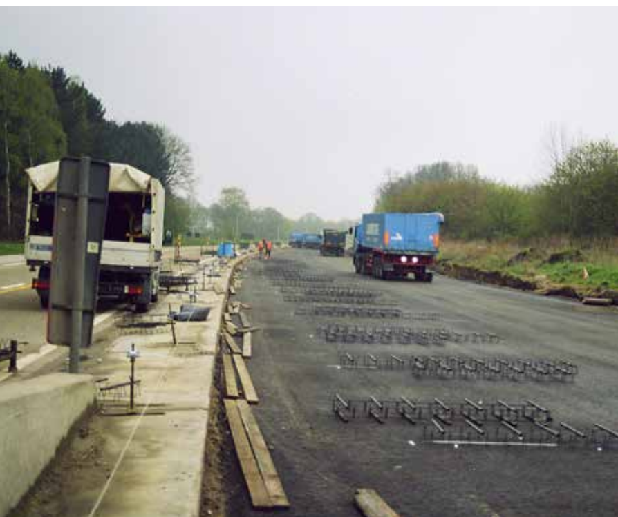
Couche intermédiaire en asphalte (Hechtel, liaison limbourgeoise Nord-Sud, 2005)
