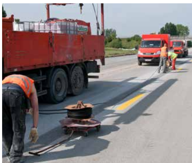
Remplissage des joints (photos ROBUCO)
