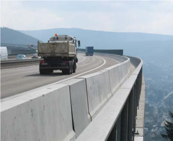
Exemple de dispositif de retenue en béton préfabriqué avec retenue très élevée (H4b) sur un viaduc
