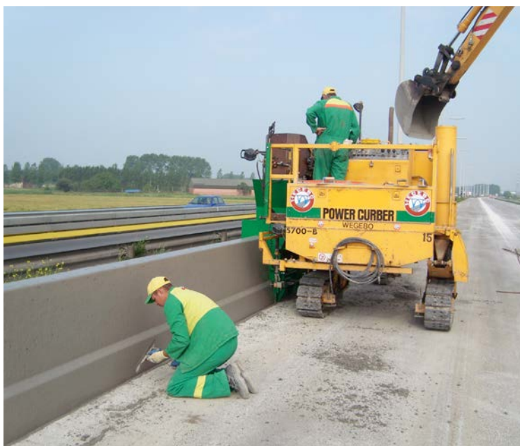
Pose d'une barrière Step en béton
