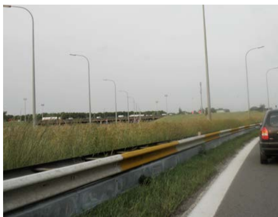
Exemple de lisse de protection pour motocyclistes posée sur une glissière de sécurité existante
