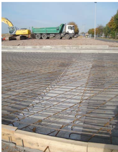
Poutre d'ancrage réalisée au niveau d'un futur joint de construction sur toute la largeur du revêtement
