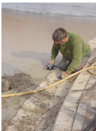
Bétonnage des amorces
