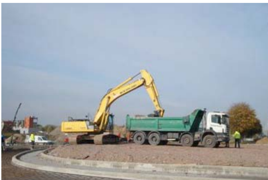
Approvisionnement du béton par l'îlot central
