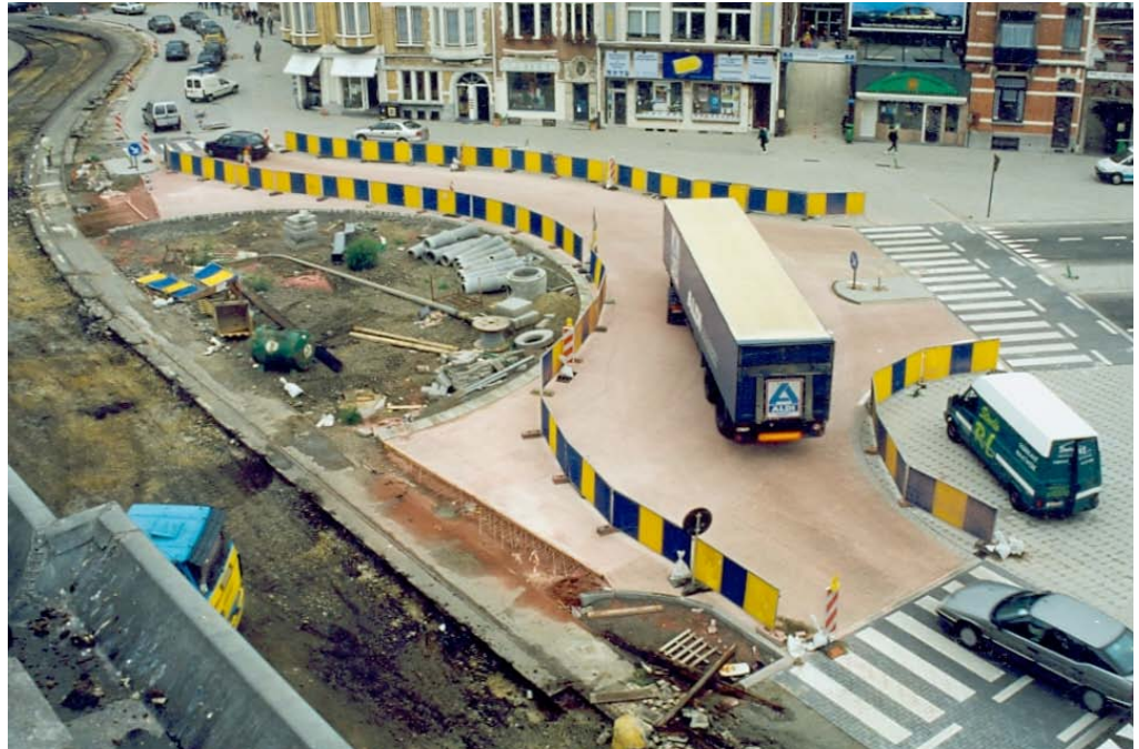
Bétonnage d'un giratoire en 2 phases distinctes
