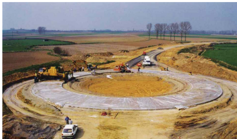
Bétonnage à la machine à coffrages glissants
