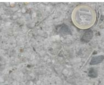
Fibres synthétiques remplaçant une armature en acier
