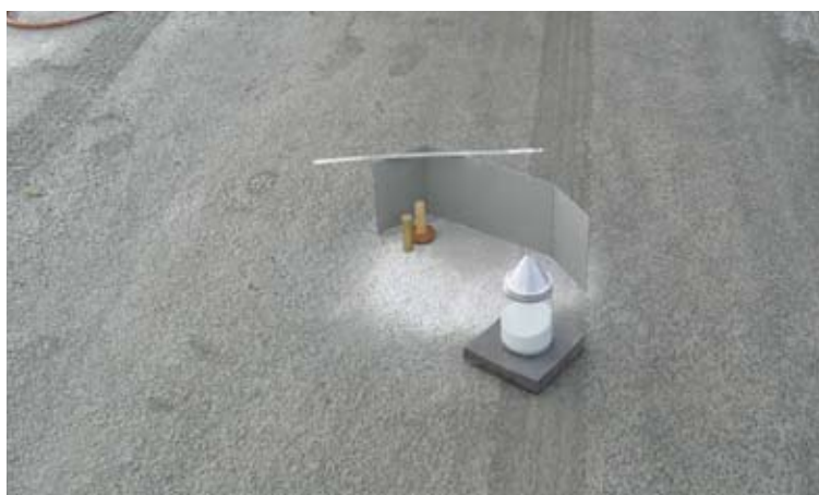
Réalisation de l'essai à la tache de sable sur chantier
