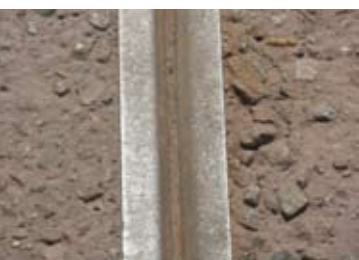
Joint de construction en acier Corten
