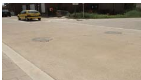
Emplacement des joints
