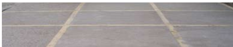
Planches d'essais sur chantier
