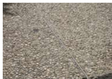
Profilé en PVC dans un joint de retrait (Abbeville, France)
