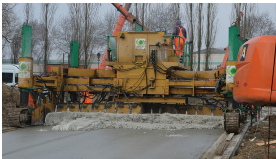
Mise en œuvre de la couche supérieure blanche composée de dioxyde de titane du revêtement bicouche à Wijnegem
