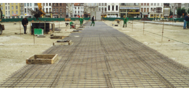
Mise en place du treillis d'armature dans la sous-couche
