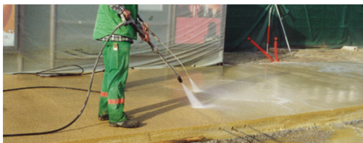
La surface est alors lavée au moyen d'un nettoyeur à haute pression
