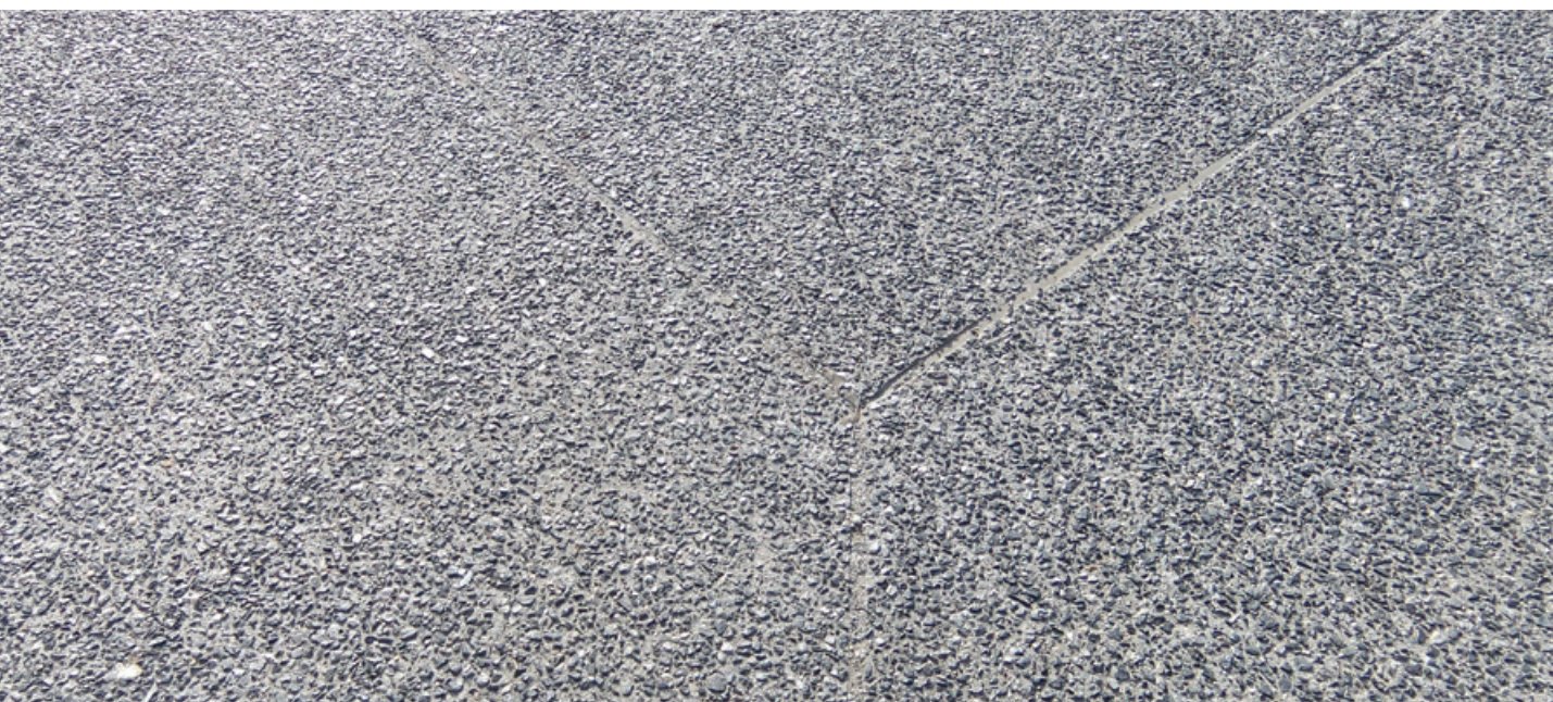
De gauche à droite : coulage et compactage de la sous-couche – mise à niveau – lissage – pulvérisation du retardateur de prise Grande photo : la surface finie après dénudage
