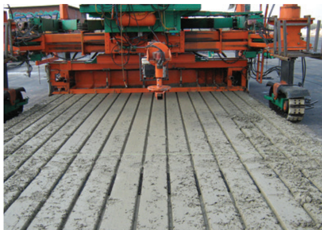
Lommel, Kristalpark : pose des goudons dans les fentes réalisées dans la couche inférieure
