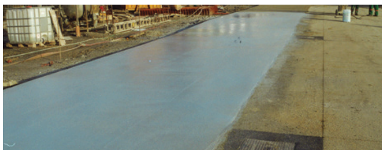
Le retardateur de prise est alors pulvérisé à la surface du béton frais
