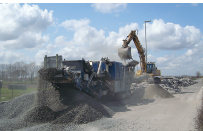
Le béton de l'ancien revêtement démolé a été transformé en nouveaux granulats dans une centrale mobile de concassage et de criblage.
