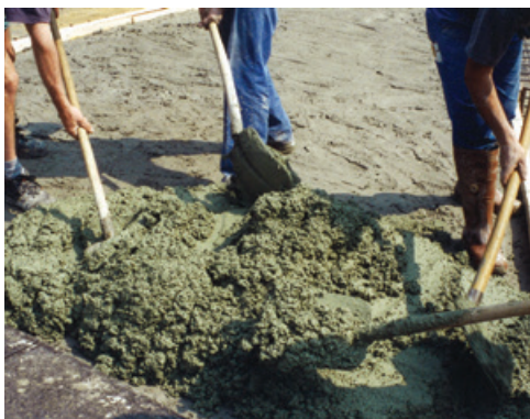
Épandage du béton de couleur verte destiné à la couche supérieure
