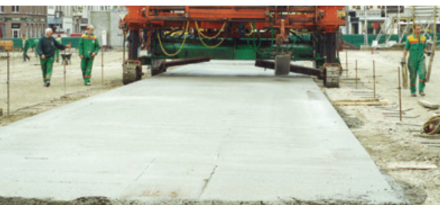
Bétonnage de la sous-couche (gauche) ...
