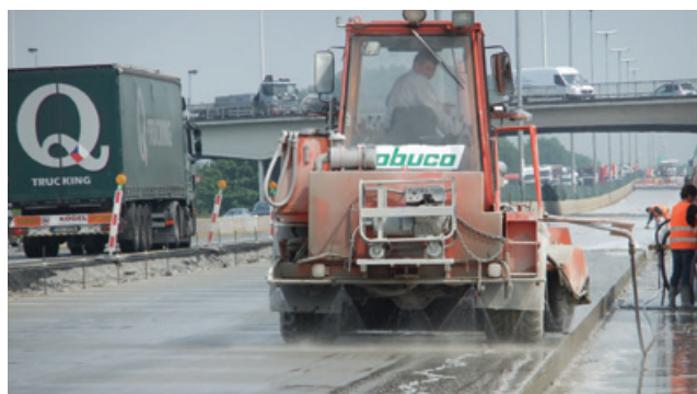
Le procédé du dénudage « chimique » d'une surface en béton : pulvérisation du retardateur de prise sur le béton frais – protection par une feuille en plastique – élimination de la couche superficielle de mortier par une brosse mécanique
