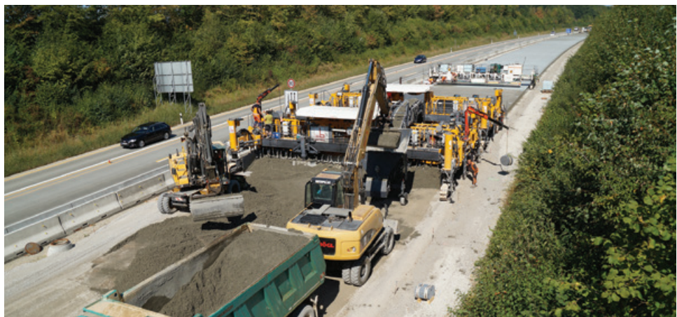
Allemagne, Würzburg, A7 : le béton de la couche supérieure est transporté sur un tapis roulant au-dessus de la première machine à coffrage glissant jusqu'à la couche inférieure (© Klaus Felsch, Heidelberg Cement)
