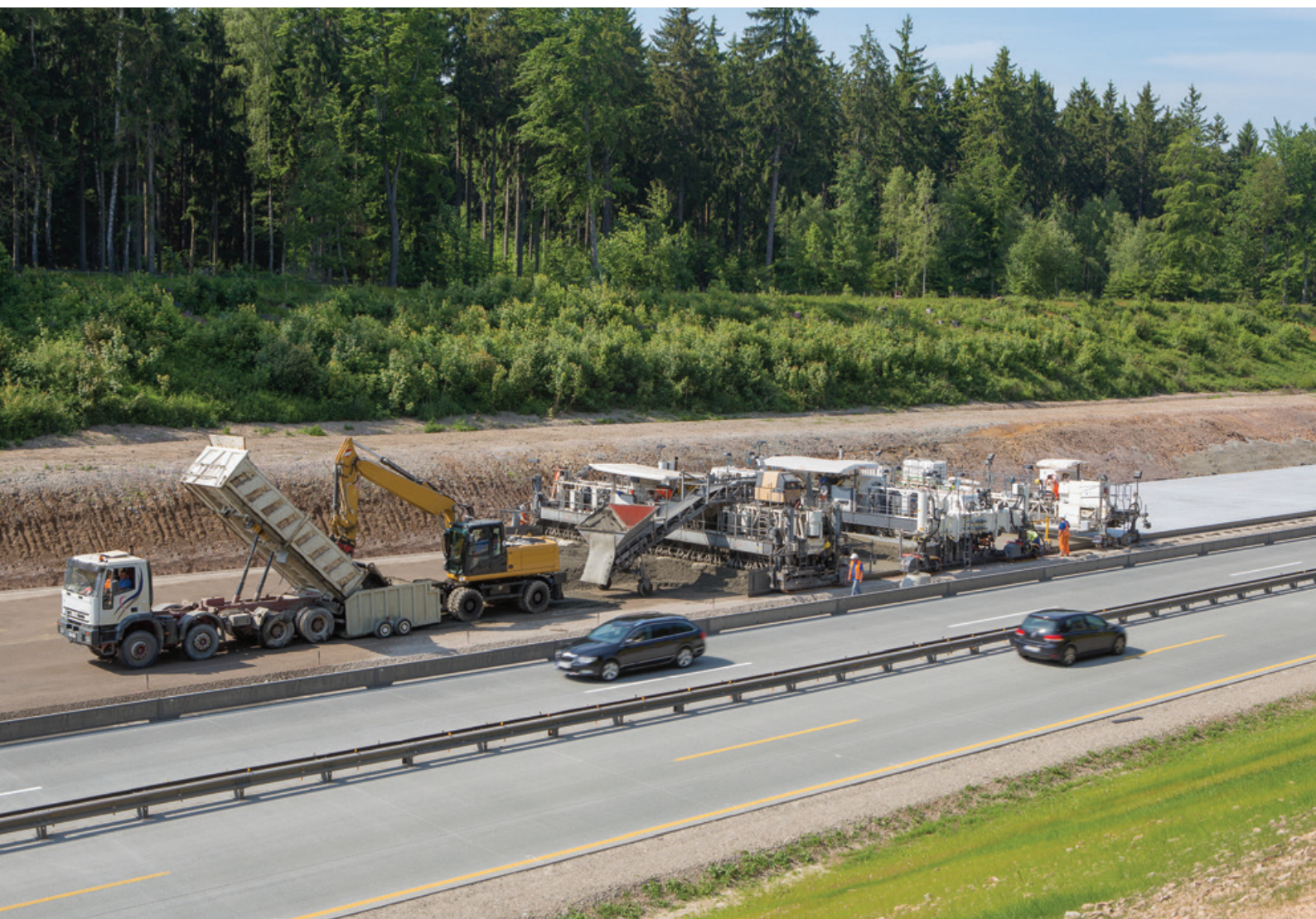
Mise en œuvre d'un revêtement bicouche à l'aide de deux machines à coffrage glissant intégrées (photo ©Wirtgen)
