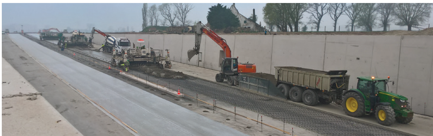
Mise en œuvre dans une section du tunnel à ciel ouvert (© Willemen)
