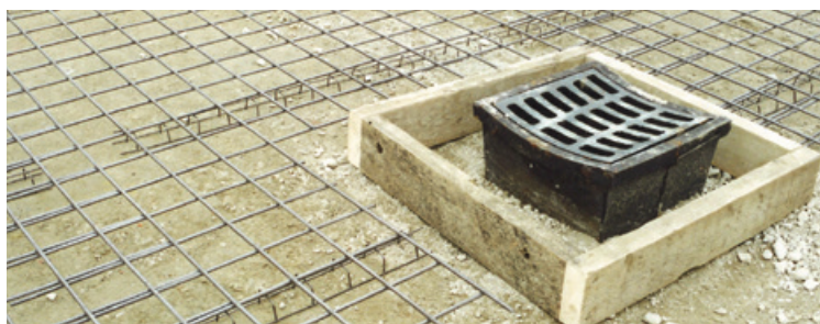
Coffrage pour le coulage manuel du béton noir autour des avaloirs
