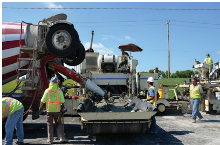
U.S. Route à péage I-90 : approvisionnement du béton pour la couche de roulement à l'aide d'un tapis roulant et finition de surface par striage fin dans le sens longitudinal
