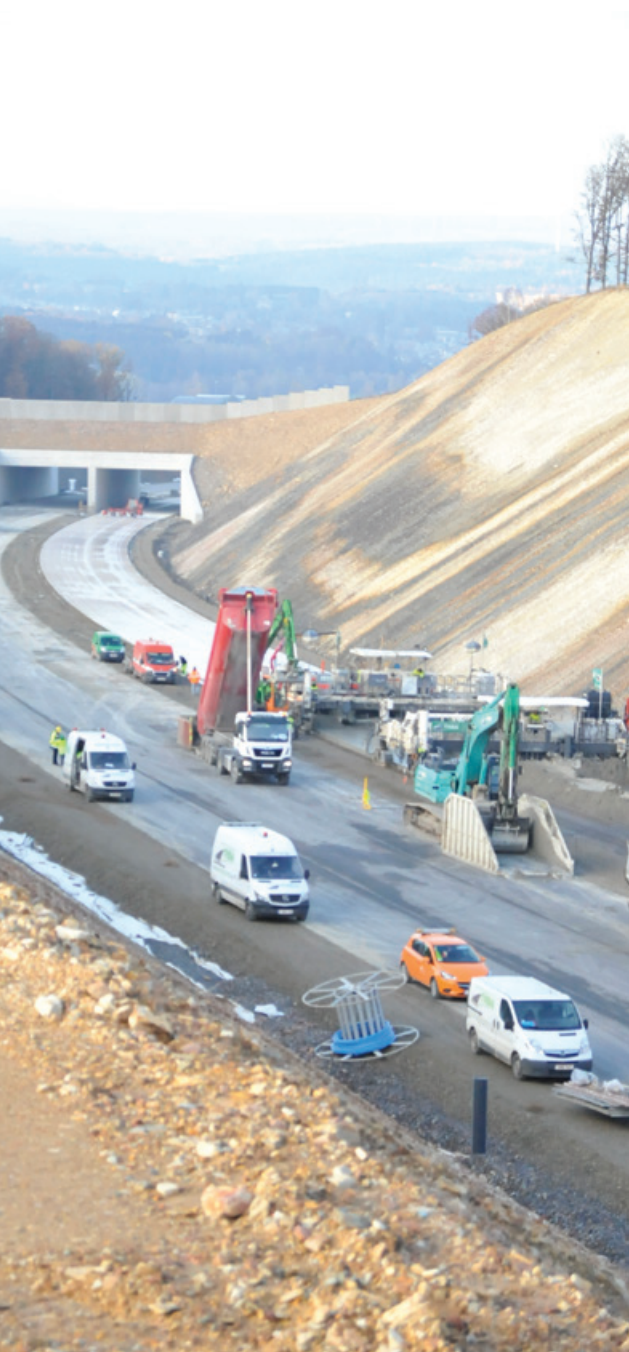
Construction de la 2ème phase du contournement à Couvin - bétonnage sur toute la largeur avec deux machines à coffrage glissant (photos chantier @ Cimbéton)
