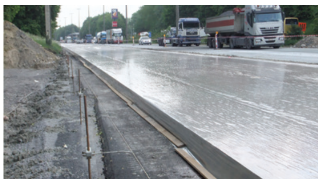
Le procédé du dénudage « chimique » d'une surface en béton : pulvérisation du retardateur de prise sur le béton frais – protection par une feuille en plastique – élimination de la couche superficielle de mortier par une brosse mécanique
