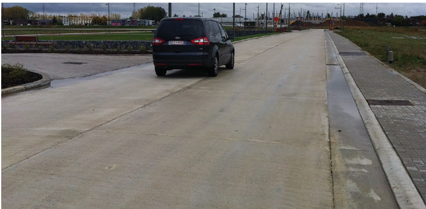
Vue sur la chaussée finie avec du béton brossé à Lier (© CRR)
