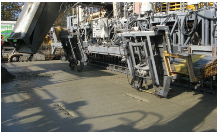
Allemagne, Trèves : goudons enfoncés par vibration dans la sous-couche
