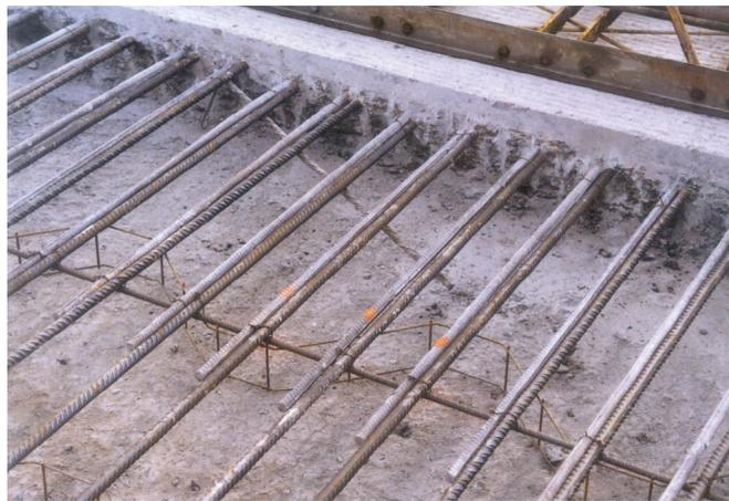
Recouvrement de l'armature dégagée et de la nouvelle armature. Le bord du béton dégagé est bien droit et propre sous l'armature existante.
