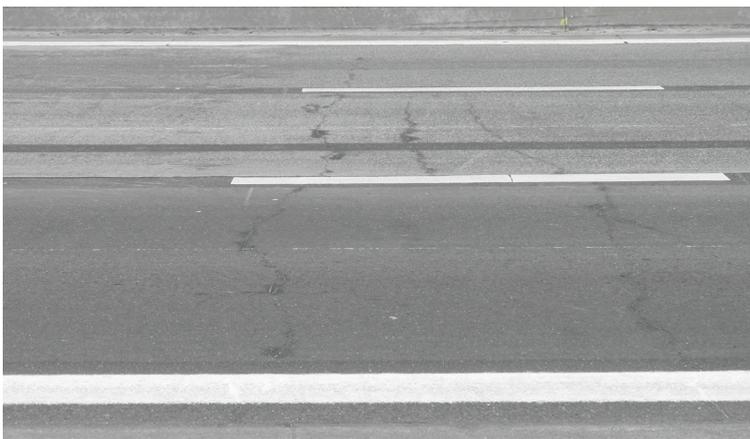
E40/A10, Affligem, BAC, vue du schéma de fissures erratique
