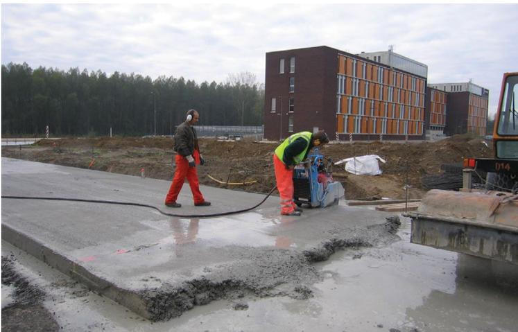
Sciage de la dernière section de béton coulée d'une route en dalles de béton
