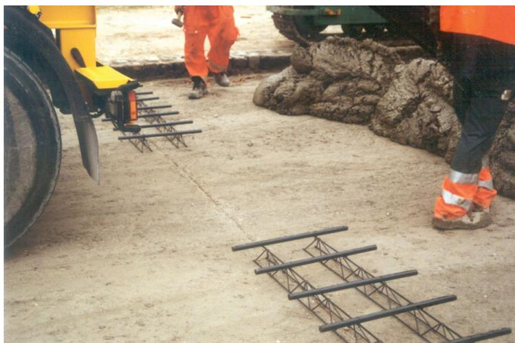
Réparation de dalles de béton - joint de retrait-flexion transversal goujonné en cours de placement sur une fondation en béton sec compacté
