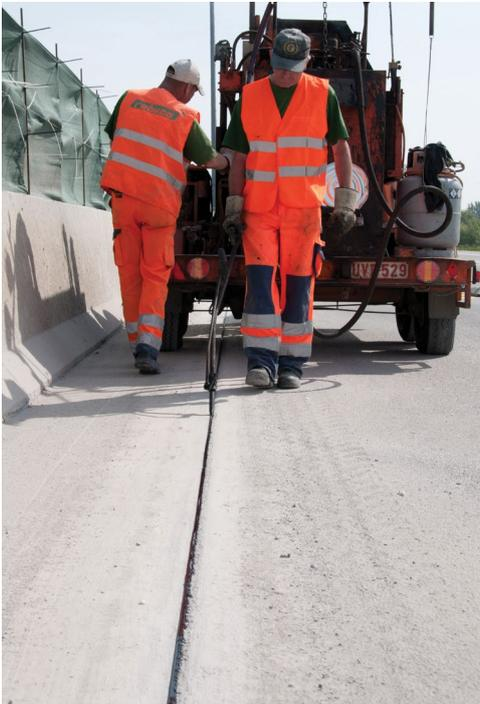
Application d'une masse de scellement à chaud dans un joint longitudinal
