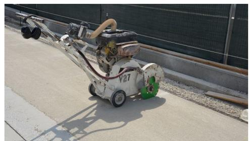
E313, Herentals : réalisation des amorces de fissuration dans du BAC
