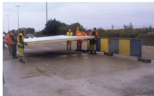
Application de panneaux isolants sur une réparation en béton en vue de conserver la chaleur d'hydratation et d'assurer un durcissement plus rapide
