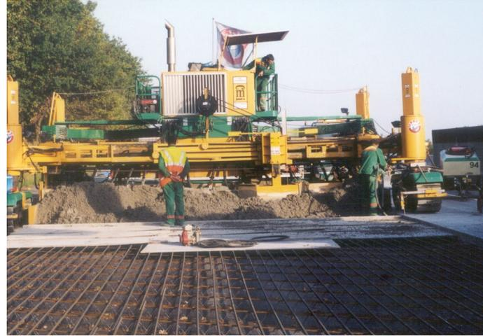
Panneaux sur le BAC, évitant l'arrivée de béton frais au-delà du joint de construction transversal.
