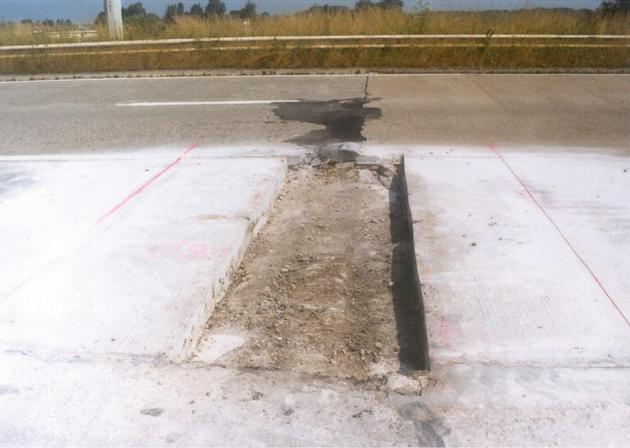
Section à réparer au moyen de traits de scie réalisés à mi-hauteur et sur la hauteur totale
