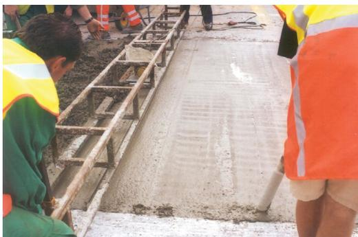
Compactage à la double poutre vibrante et à l'aiguille vibrante sur les bords
