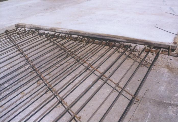
Joint de construction transversal en BAC (veiller à la verticalité du joint)
