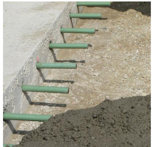
Joint de construction transversal goujonné
