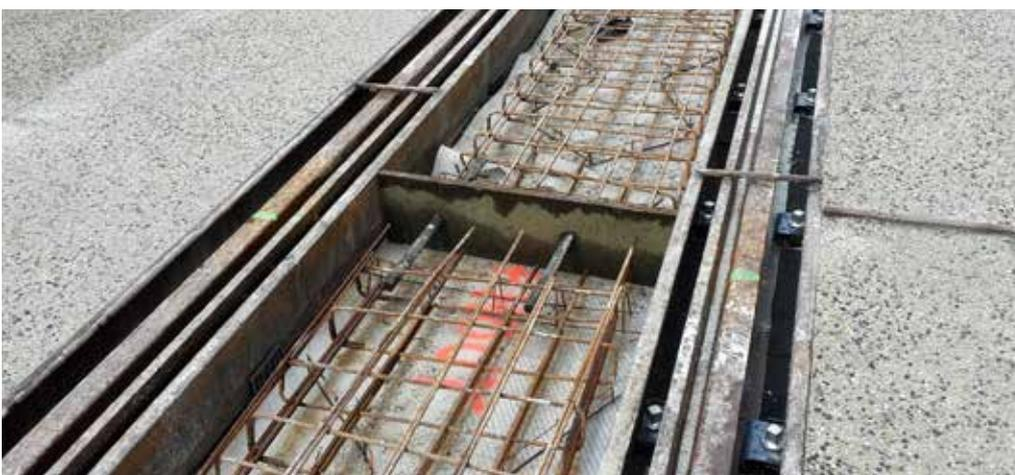
*Ici, les couches de béton inférieure et supérieure sont isolées par un géotextile. Dans ce cas, la dalle supérieure est doublement armée. (Photo : AB-Roads)*
