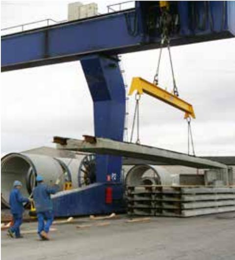
Dalle préfabriquée à rails intégrés
