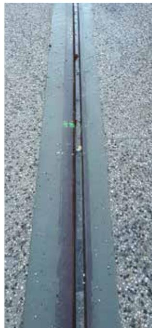
*Gand, Kouter : Gorge dans laquelle les rails sont fixés ponctuellement au moyen de boulons; le coffrage latéral est ensuite éventuellement ôté et l'espace entre les rails et le béton est rempli au moyen d'un élastomère (fixation « hybride », au moyen de boulons de serrage mais potentiellement remplaçable).*
