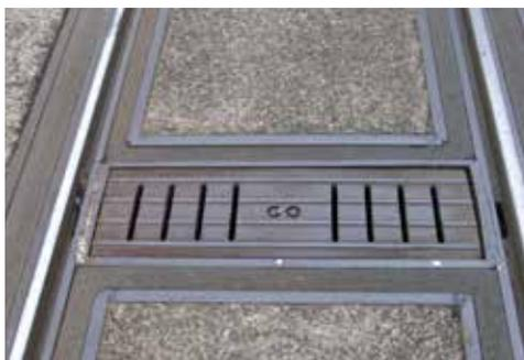
*Gand, Korte Meer et Mortsel, Liersesteenweg – l'aiguillage intégré, le système de drainage de voie et d'autres accessoires nécessitent un détail spécifique de conception et d'exécution. Au droit des aiguillages, l'adjonction d'une plaque métallique rapportée de forme triangulaire permet d'éviter la présence d'éléments aigus en béton*
