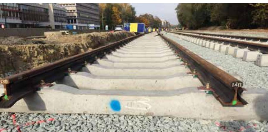
*Bruxelles – exemple de fondation en empierrement non lié et, par-dessus, les traverses en béton, scellées ensuite par coulage intermédiaire de béton
