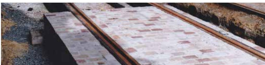
*Dalle préfabriquée en béton à pavés en pierre naturelle intégrés*
