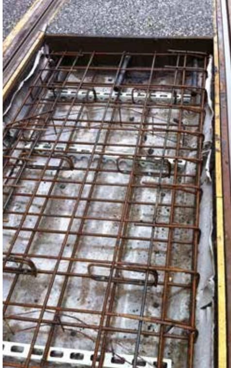
*Vue de l'armature longitudinale et des étriers transversaux de la couche supérieure de béton (Photo : OCW)*
