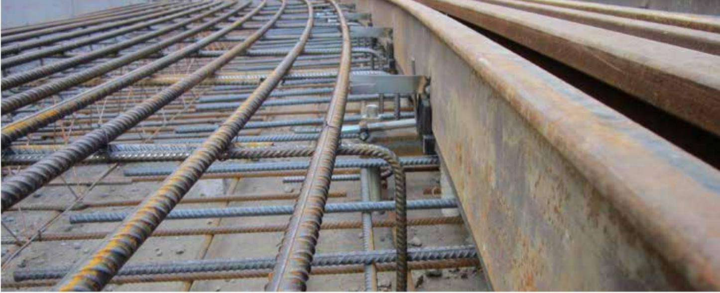
*Les étriers soutenant l'armature longitudinale servent également à solidariser les couches inférieure et supérieure de béton (Photo : De Lijn)*
