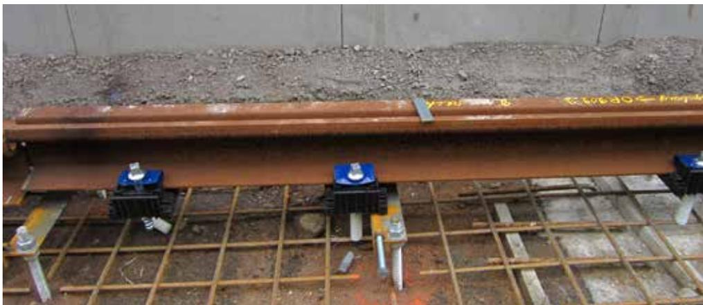
*Rails montés sur une fondation au moyen de tiges filetées et de vis de réglage. La couche inférieure de béton sera coulée après la pose des rails (Photo De Lijn)*
