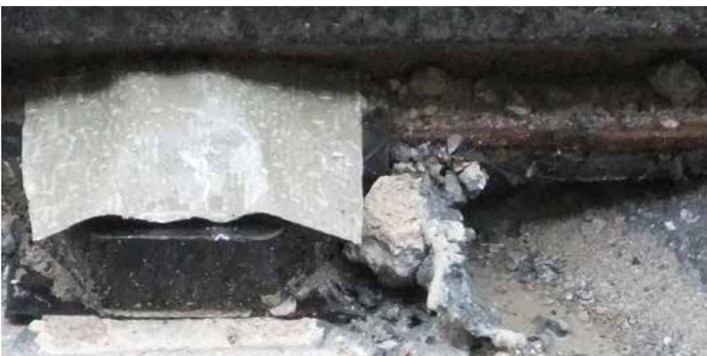
*Cache de protection sur une vis, permettant le remplacement ultérieur des rails*
